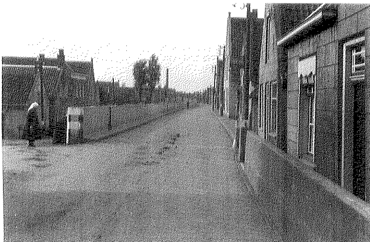
7. FUTTERSHOEK. De waterkeering gaat hier van rechts naar links dwars over den weg. Schotbalkopening = wegbreedte.
