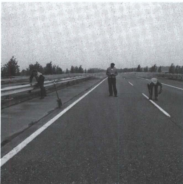
Werkzaamheden aan de vangrail (1989)
