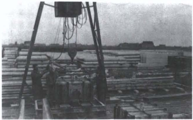
Het vervoer van betonblokken voor de Westkapelse zeedijk
