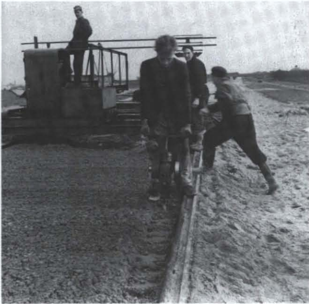
Het trillen van beton
