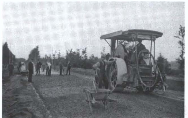
Walsen van asfaltsteenslag (jaren '20)
