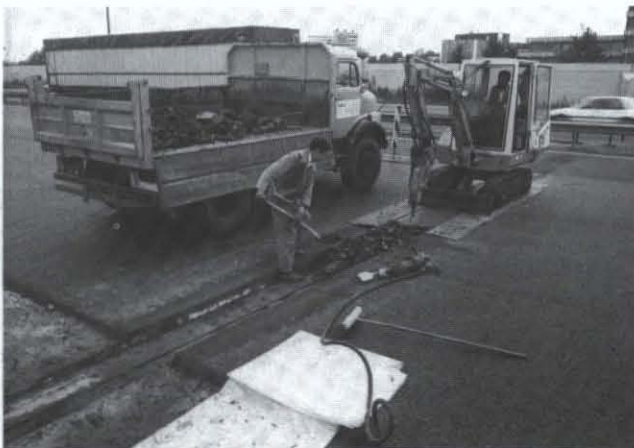
Het zagen van voegen op een viaduct in RW 28 bij Zwolle
