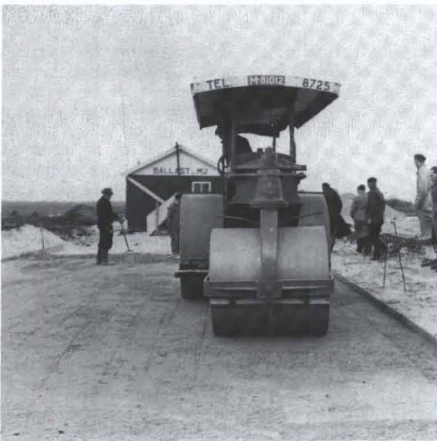
Het walsen van de betonfundering voor de asfaltverharding
