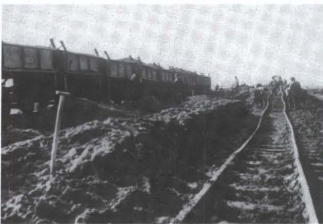
Aanvoer van zand door kipkarren voor de aanleg van RW 12 in aanleg
