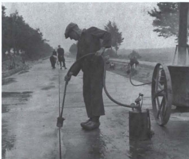
Aanleg van een betonweg in Friesland (jaren '30)
