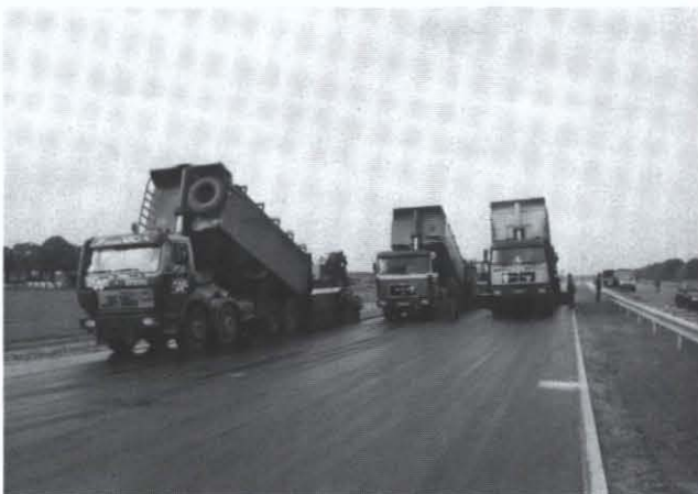
Het aanbrengen van zeer open asfaltbeton tijdens de aanleg van RW 73
