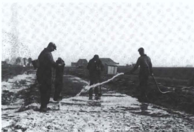
Grondwerken, inwateren en stampen van de fundering
