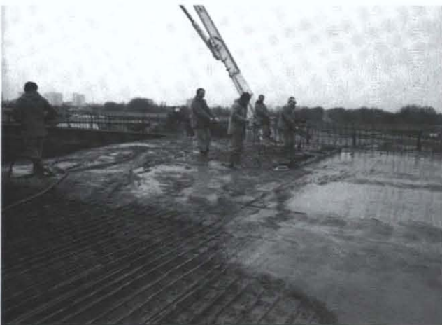
Afwerken betonnen vloer in het viaduct De Gooise knoop
