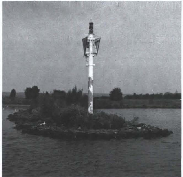
Moderne kribverlichting nabij het stuwcomplex bij Amerongen
