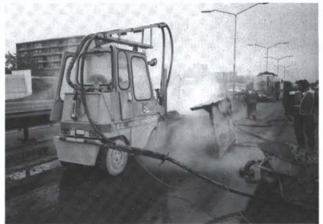
Asfalteringswerkzaamheden aan RW 28 in de dienstkring Zwolle
