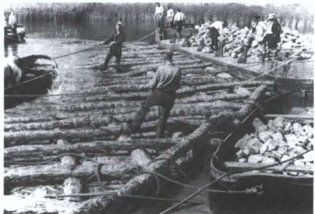
Bodembescherming met rijshout (jaren '30)
