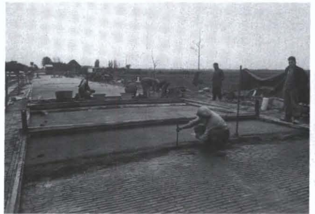
De aanleg van een klinkerweg (jaren '30)
