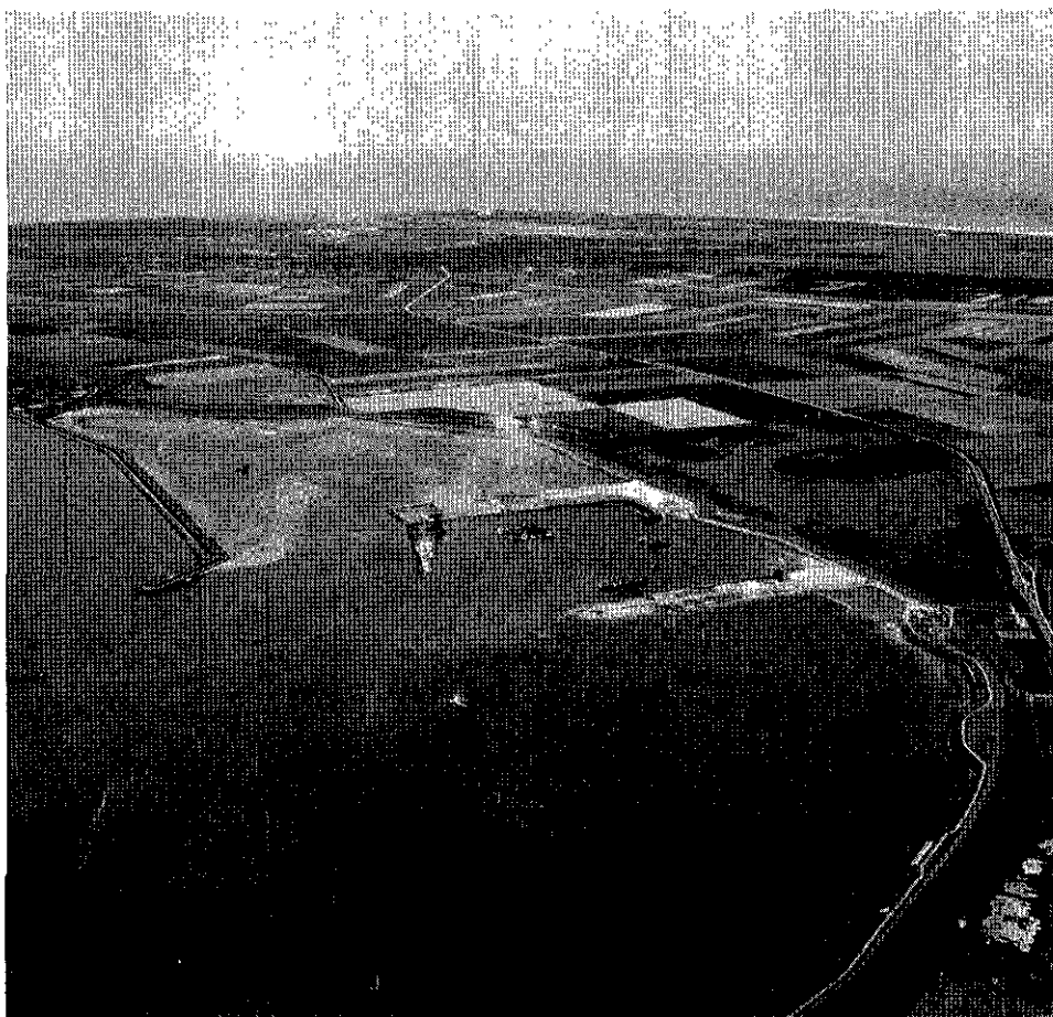
De werkhaven 'Scheiphoeck' op Schouwen in aanleg. Foto van 31-7-'67
