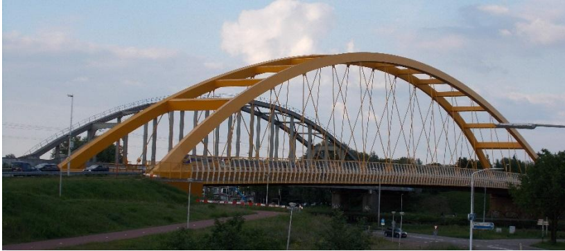
Afbeelding 4.5 De gele Hogeweidebrug aan de westkant van Utrecht, welke het Amsterdam Rijnkanaal overspant.
