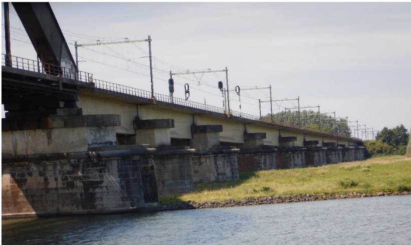
Afbeelding 4.4 Bestaande aanbruggen aan noordzijde spoorbrug Culemborg
