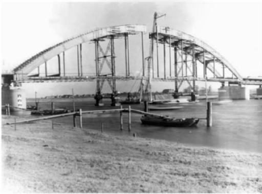
Afbeelding 4.1 Oude foto van de bouw van de brug met 2 hulppijlers in de Lek.
