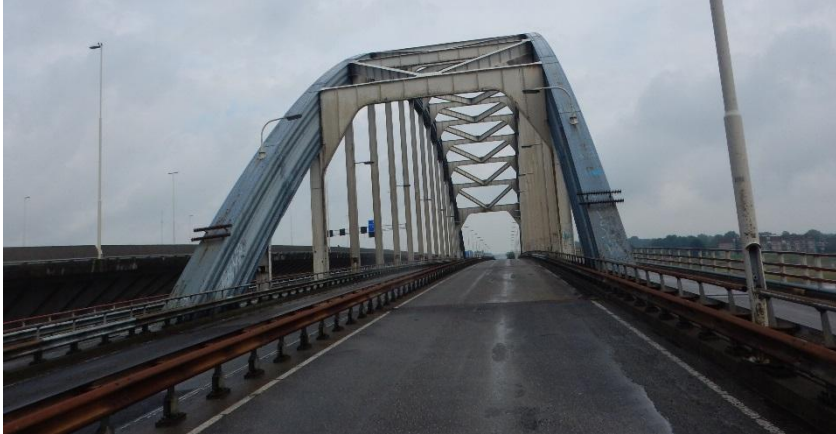
Afbeelding 3.3 Overzichtfoto van de stalen boogbrug
