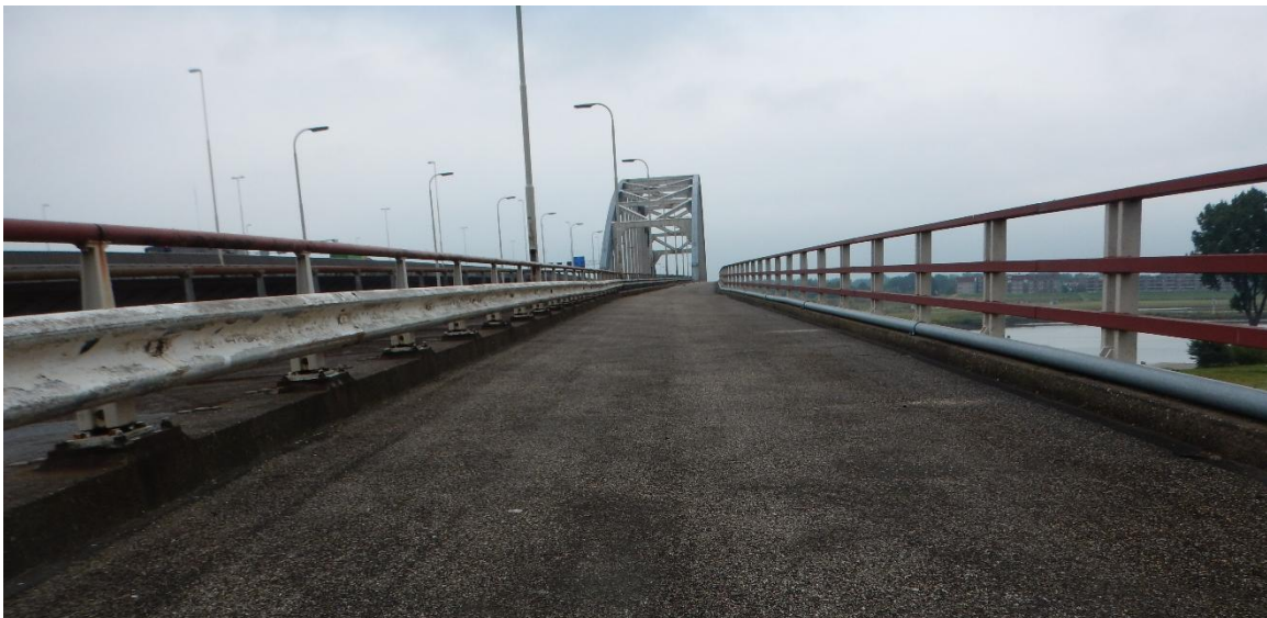
Afbeelding 1.1 Het fietspad dat onderdeel uitmaakt van de boogbrug Vianen
