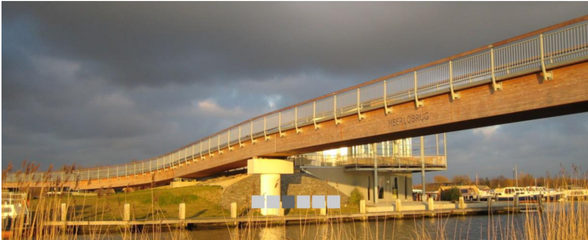
Figuur 2: De Meerlobrug (2006) bij IJsselstein (NL) met gelamineerd naaldhouten constructie onder het brugdek. De totale lengte is 117 meter. Foto: F. Miebach/IB-Miebach.
