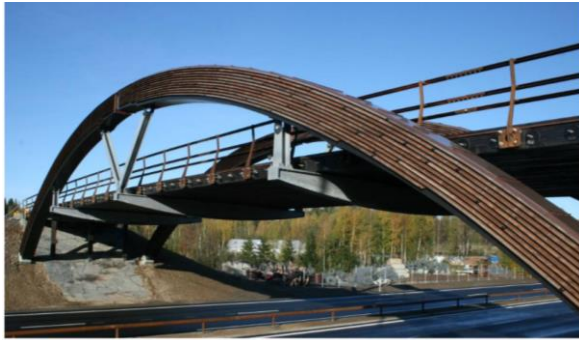
Skogsrud brug 49 over de E6 nabij Tangen (Hedmark), 2009. 49 m lengte (37 m overspanning); breedte 7,5 m.
