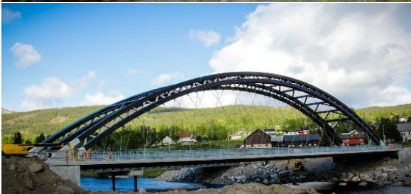
Steien brug , 51 Highway 3 over de Glomma Rivier, Alvdal (Hedmark), 2014-2015. De grootste overspanning van Noorwegen met 88,2m en een breedte: 20m.
