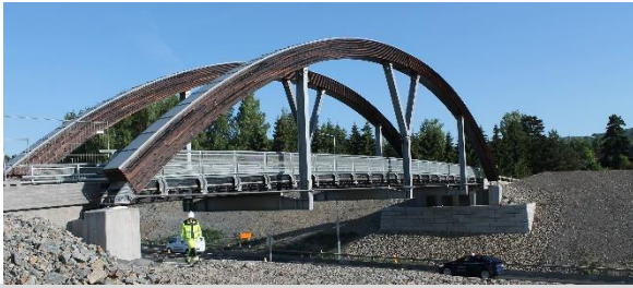
Trekvarten brug, over de E6, Brumunddal, 2019. 58
