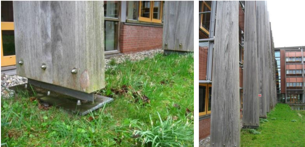
Figuur 3-4: Gelamineerd Iroko toegepast sinds 1996 (foto's: 2010). Foto's: De Groot Vroomshoop.
