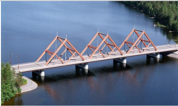
Composite Structure Bridge, Vihantasalmi (1999). 60 Een van de langste houten verkeersbruggen op snelwegen (snelweg no. 5). Lengte: 182 meter (168 meter overspanning). Breedte 14 meter.
