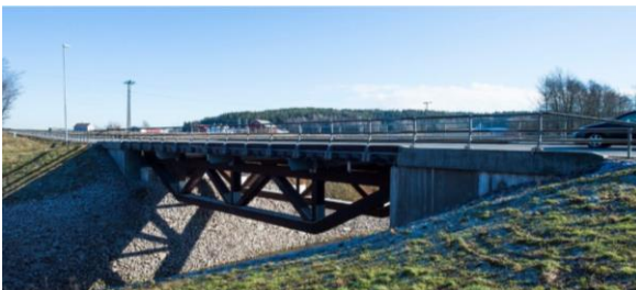
Moumbekken brug 52 , Highway 111 nabij Frederikstad, 2014. 25,4 meter lengte (max. overspanning 7,3 meter). Breedte 9 meter.
