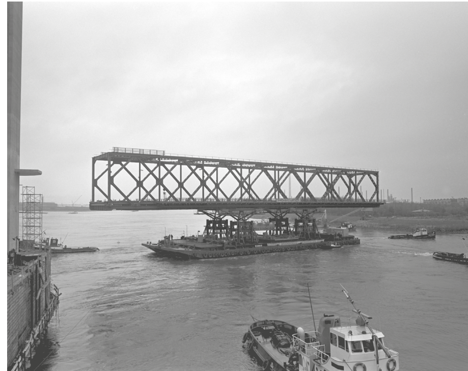
Figuur 4. Vier delen van de oude Moerdijkbrug worden gebruikt ter vervanging van de oude Spijkenissebrug over de Oude Maas.
