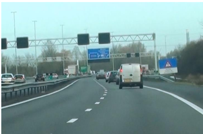
Figuur 4.8: Parallax-effect door wegverloop en de bewegwijzering van naastgelegen rijbaan.
