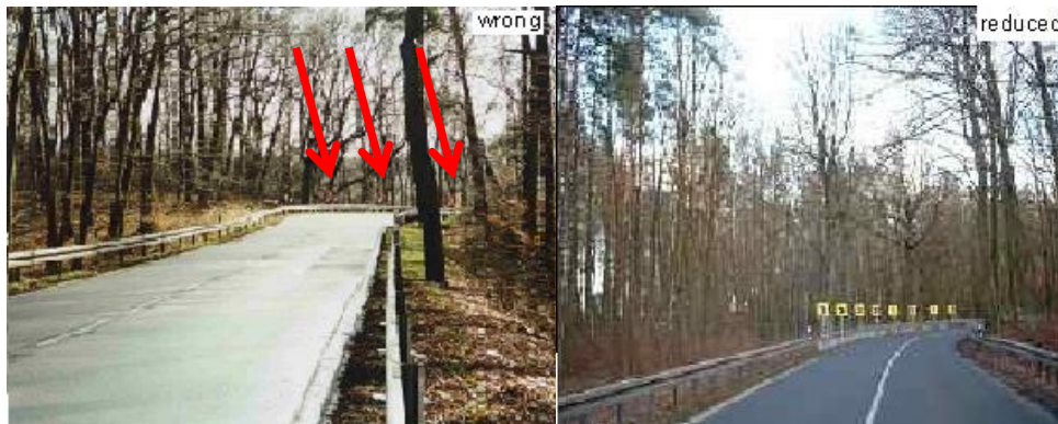
Figuur 1.1: Voorbeeld slechte zichtbaarheid door een gebrek aan contrast, in de linker figuur zijn de bochtschilden (bij rode pijlen) die het verloop van de bocht zouden moeten markeren nauwelijks zichtbaar; In de rechter foto is het contrast verbeterd met de achtergrondschilden (Birth, 2014)
