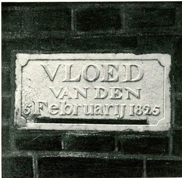
Fig. 16. Peilmerksteen van den stormvloed van 4—5 Februari 1825 in den zuidwestelijken frontmuur van de Wateringsche sluis te Maassluis. (Zie ook fig. 10).
