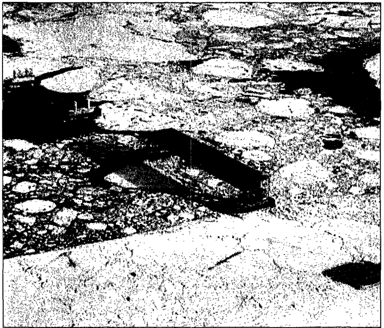
Drijfs bij de in aanbouw zijnde Haringvlietbrug
