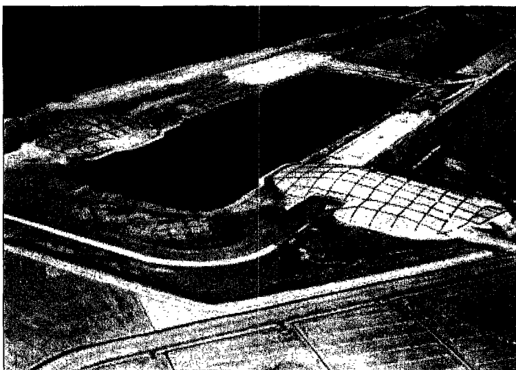
Bouwput schutsluizen in 1962
