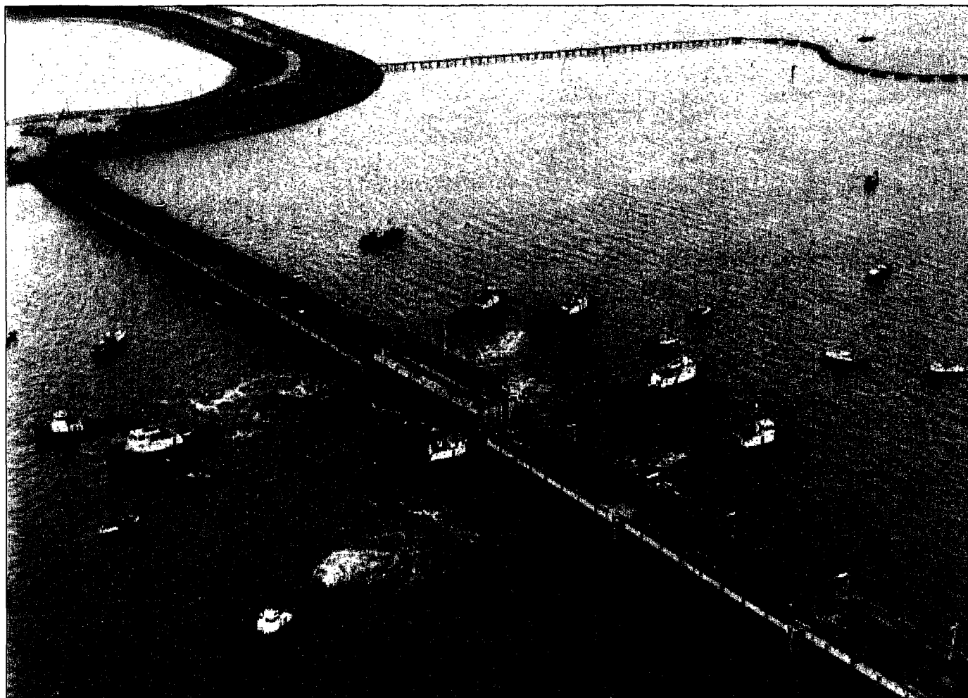
De laatste caisson zinkt naar de drempel
