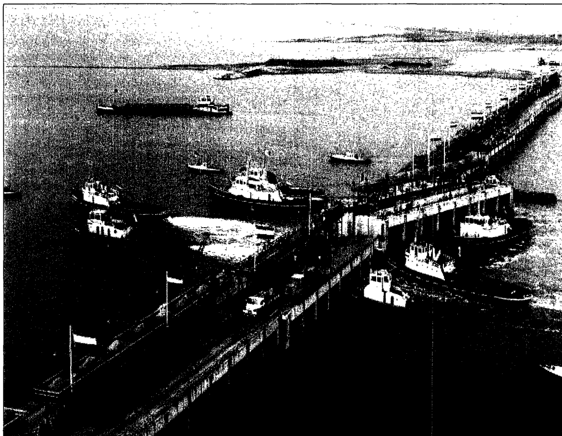
De laatste caisson wordt op zijn plaats gebracht
