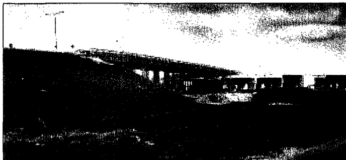
Baileybrug gezien vanaf zuidzijde
