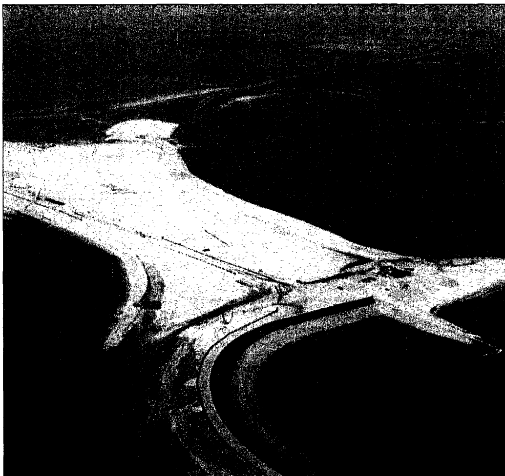
Caissons onder het zand in september 1969
