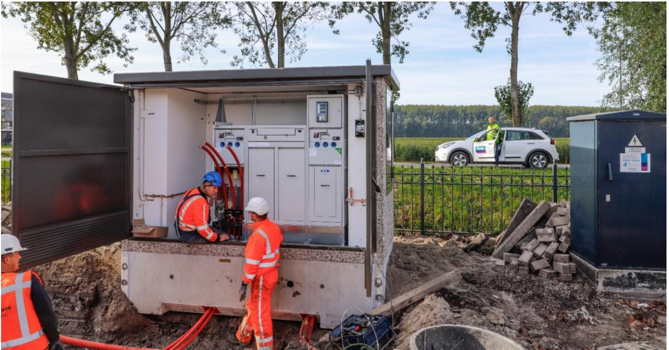
Figuur 20: De realisatie van een grote aansluiting bij een klant
