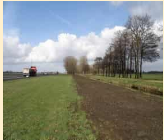
Bagger achterlaten is schadelijk voor de erosiebestendigheid, de draagkracht van de berm en voor de natuurkwaliteit. (Foto Saskia Wielenga)
