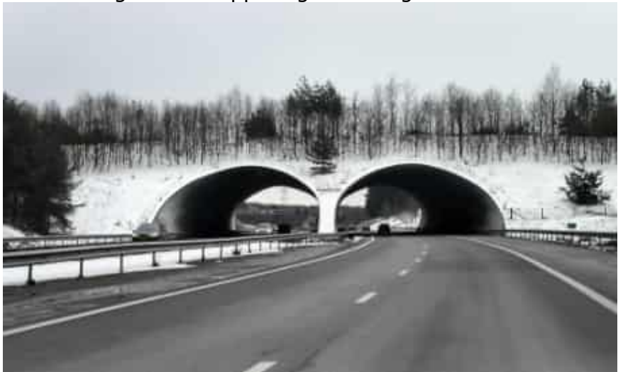
Ecoduct "Woeste Hoeve" over de A50. Foto Bart Stolte.
