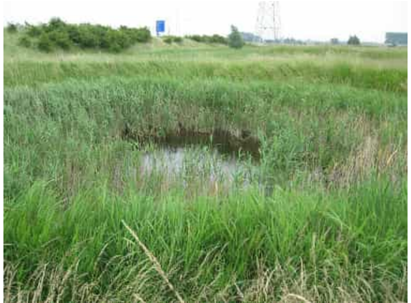
Waterpartijen in knooppunten mogen niet helemaal dichtgroeien: de opvang- en doorvoerfunctie voor water, en natuurwaarden komen dan in het geding. Foto Peter-Jan Keizer.
