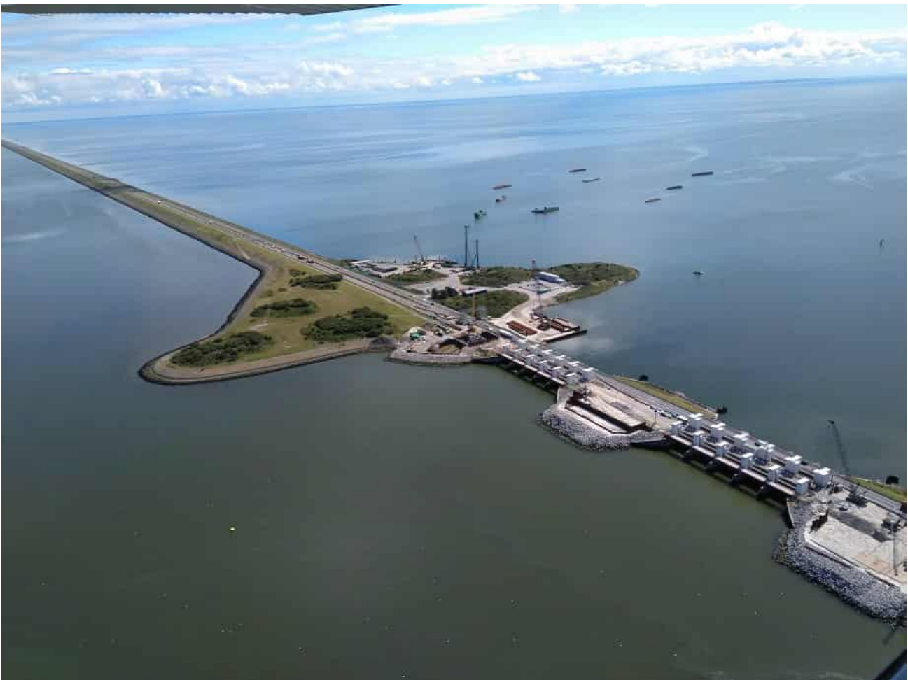
Op de afsluitdijk is zowel het onderhoud van de steenconstructie als de erosiebestendigheid van de dijkvegetatie van groot belang. Beheer van 2x maaien per jaar met afvoer van het maaisel bevordert door een intensieve doorworteling de erosiebestendigheid van de zode en de bovenste bodemlaag. Foto Mennobart van Eerden.
