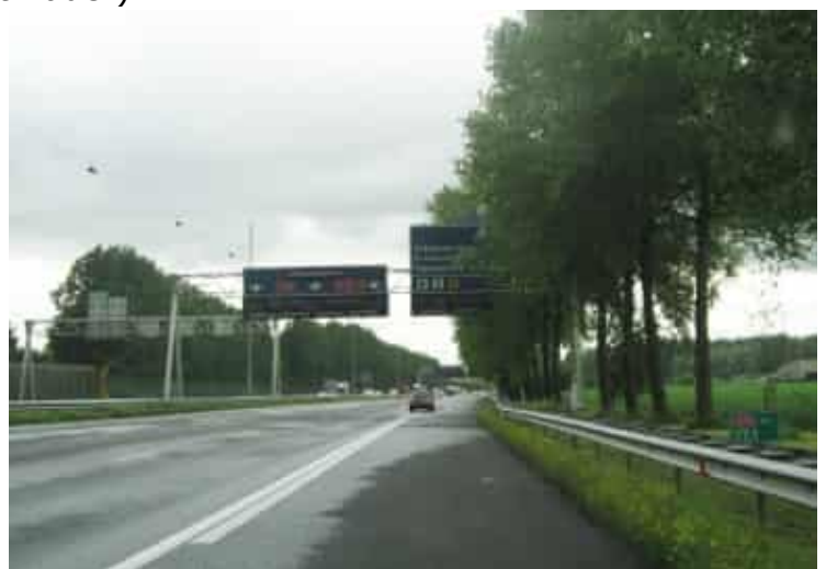
Beplanting accentueert het verloop van de weg. De beplanting mag de leesbaarheid van borden niet belemmeren. Foto Archief Rijkswaterstaat.
