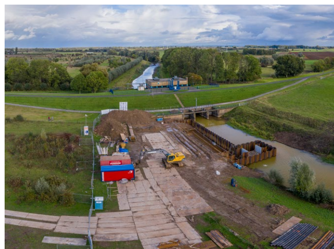
Bouw van de vispassage bij gemaal Kandia | Rijkswaterstaat
