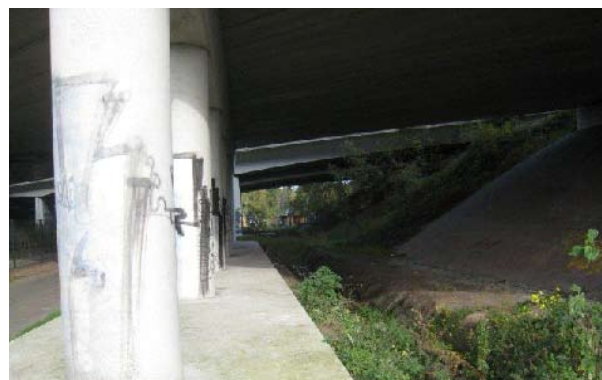
Zone tussen fietspad en landhoofd
