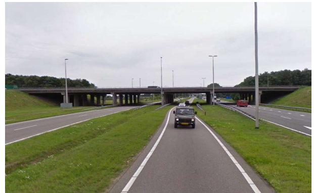
vanaf de N301 richting het zuiden
