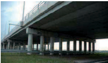
kolommen en balk zijn niet geïntegreerd in één vorm
