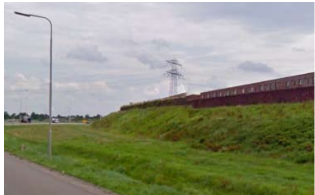
grondwal met schanskorven bij Nieuwland
