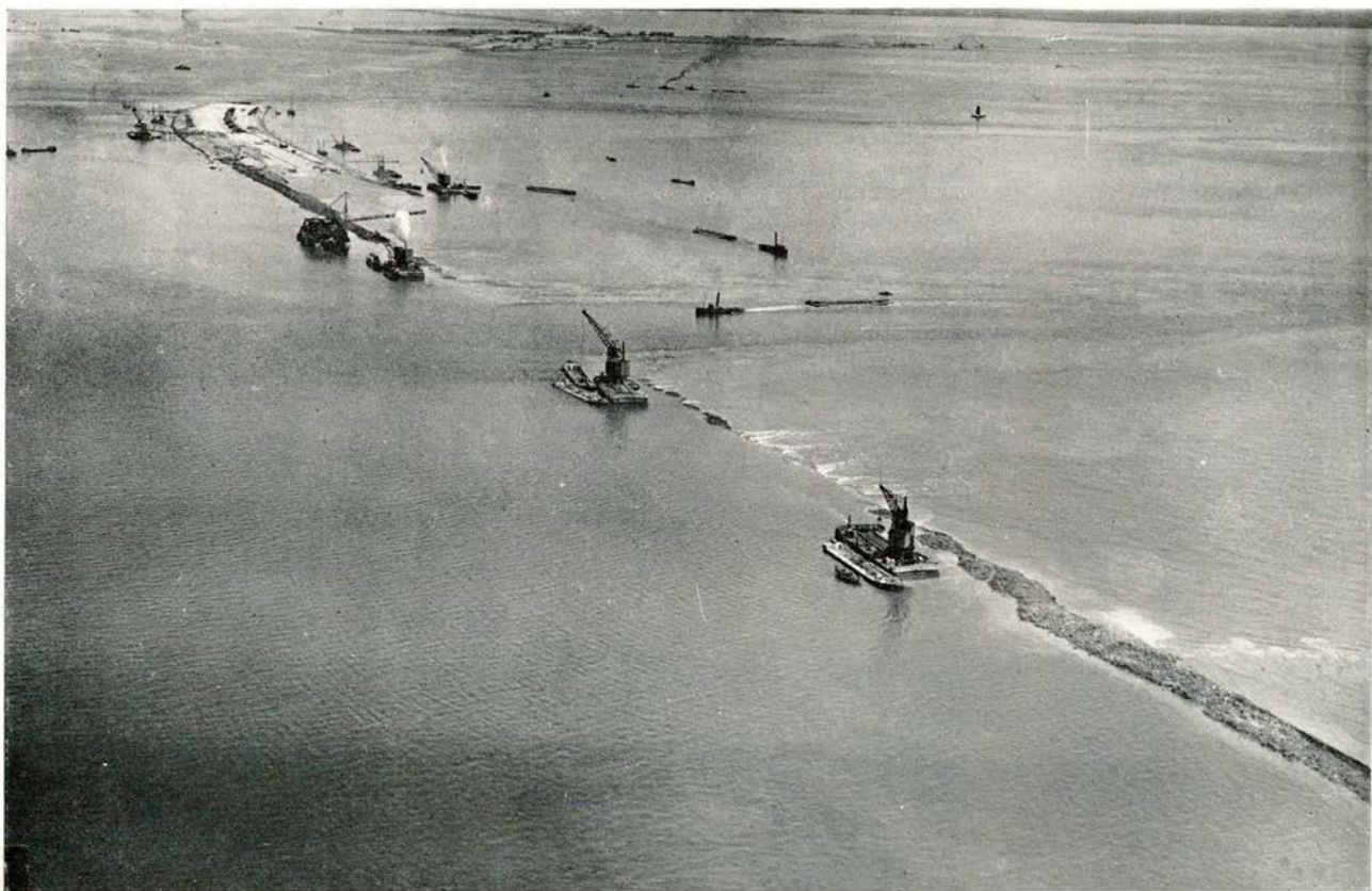
Nº. 2. Dijkvak in aanbouw ten Oosten van „Breezand”. Op achtergrond: sluitgat „Middelgronden” en bouwput op het Kornwerderzand.
