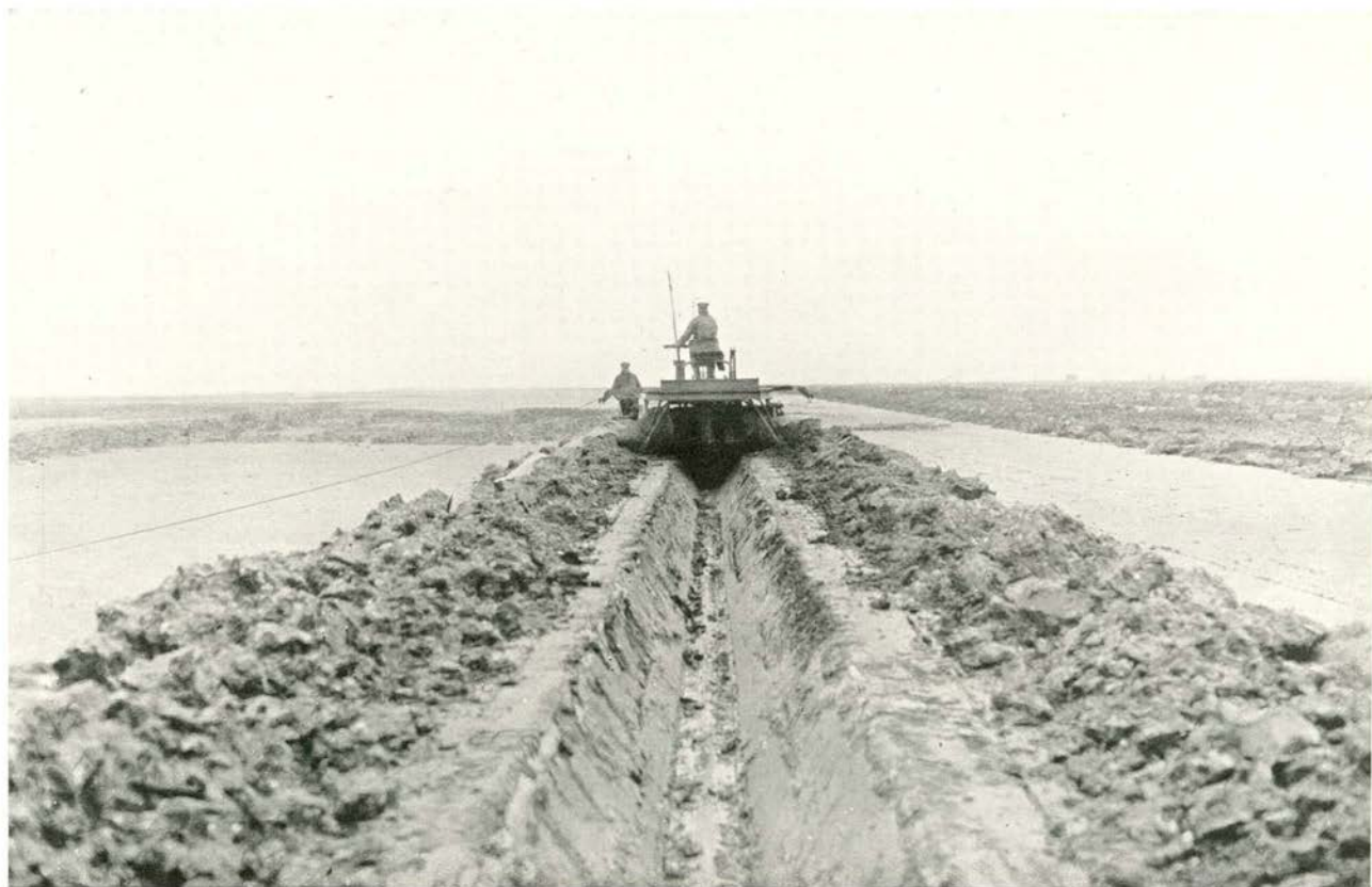
N o . 4. De door den greppelploeg getrokken greppel met een bovenbreedte van 1.15 m, een bodembreedte van 0.25 m en een diepte van 0.60 m (op zandgrond).
