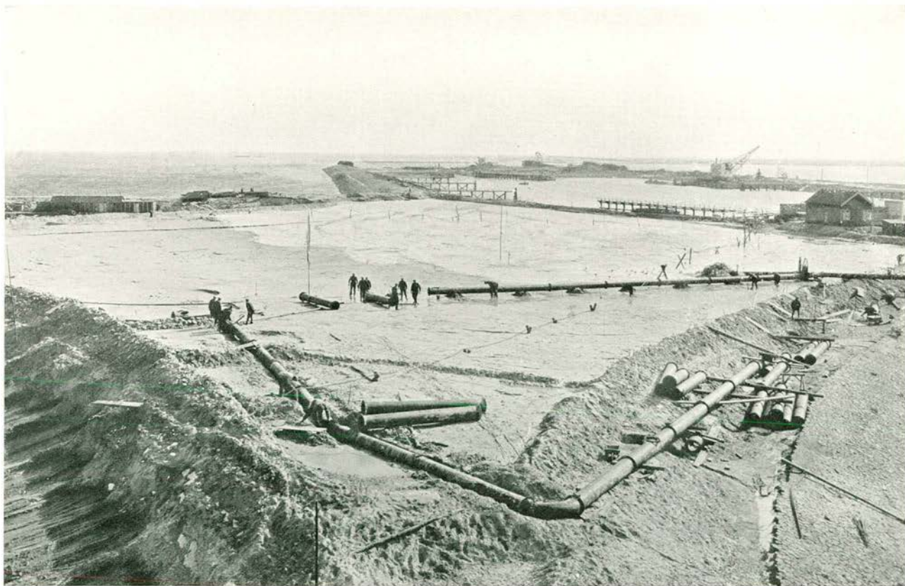
N o . 1. Zandplateau in opspuiting te Den Oever tusschen draaibruggen en uitwateringssluizen. Gezien uit het Noorden.
