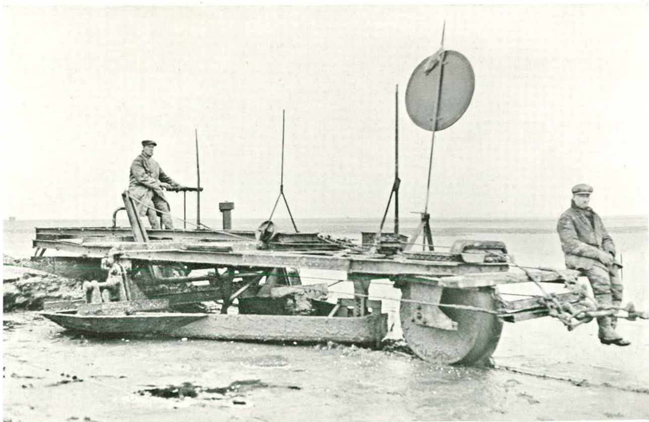
N o . 3. De greppelploeg, systeem van Dyk-McLaren tijdens het trekken van een greppel.
