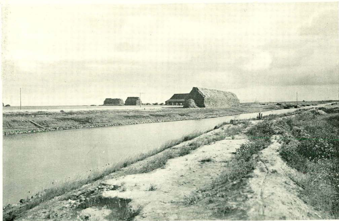
N o . 3. Afgewerkt kanaal De Haukes—Sluis I met voltooide boordvoorziening (Sept. 1931). Aan de overzijde landbouwschuur en strooschelven.
