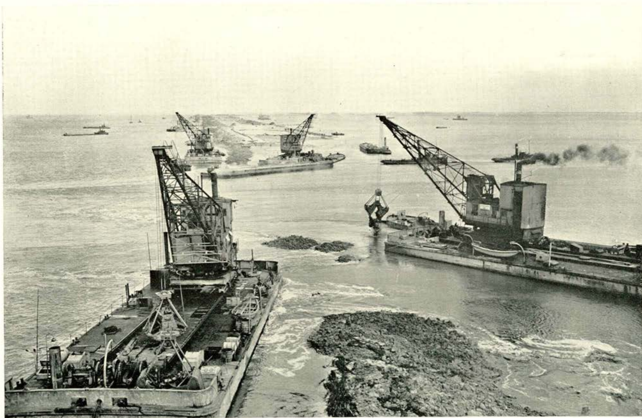
Nº. 2. Sluiting van den keileemdamm in de Blinde Geul 8 Augustus 1931.
