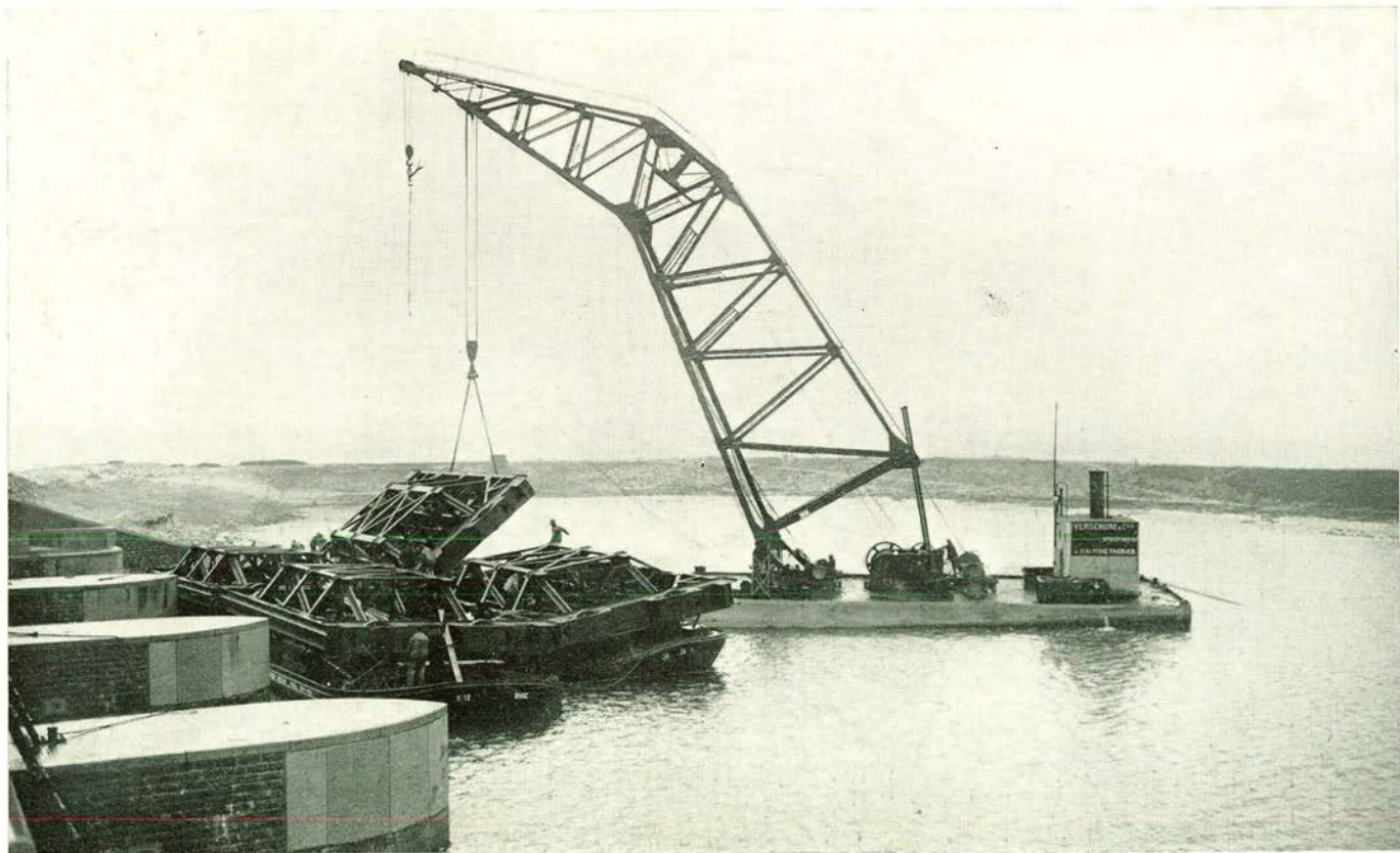
N o . 1. Plaatsen van de schuiven in de uitwateringssluizen bij Den Oever. Het lichten van een aangevoerde schuif van de zolderschuit.
