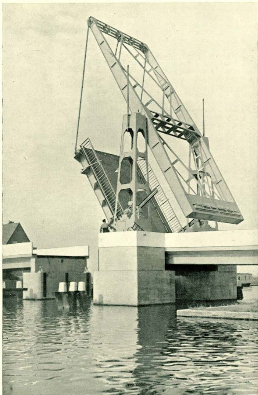
N o . 1. Ophaalbrug over de Wieringerwerfvaart bij Middenmeer. Brug half geopend.
