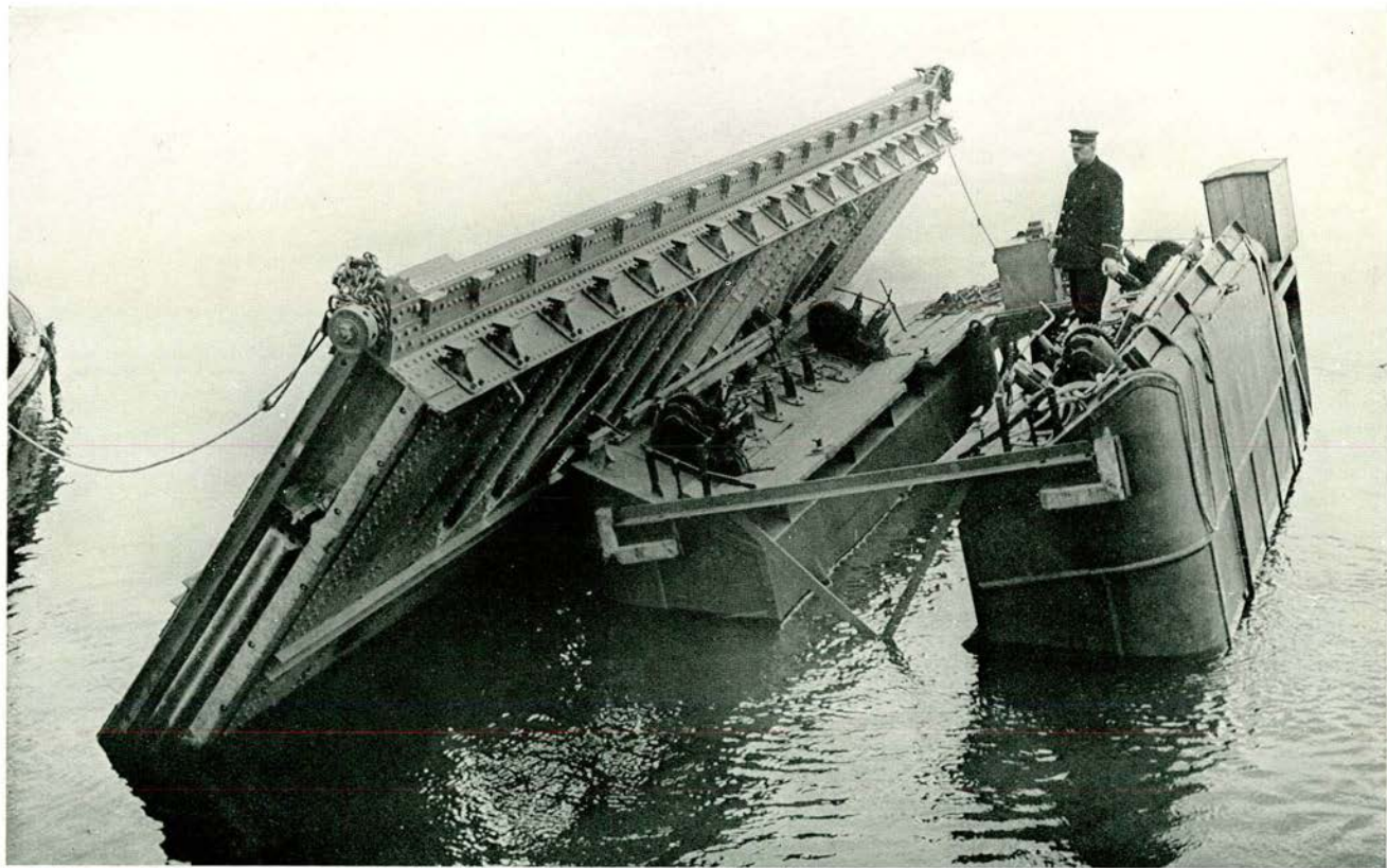
N o . 1. Drijvend afsluitschot, gedeeltelijk ondersteund door beunponton.
