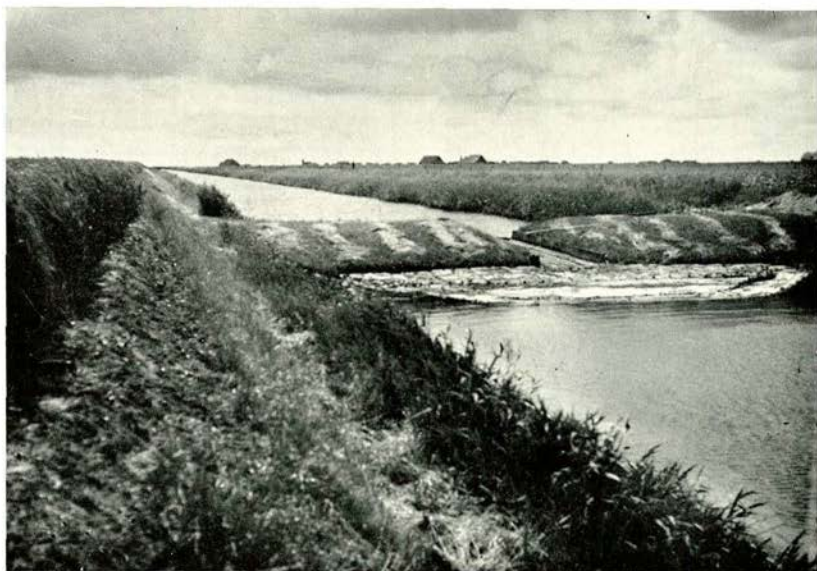
N o . 9. Dam in de Middenmeertoct, welke water opstuwt tot een hoogte van 0,55 m boven het verlaagde peil in Polderafdeeling III.
