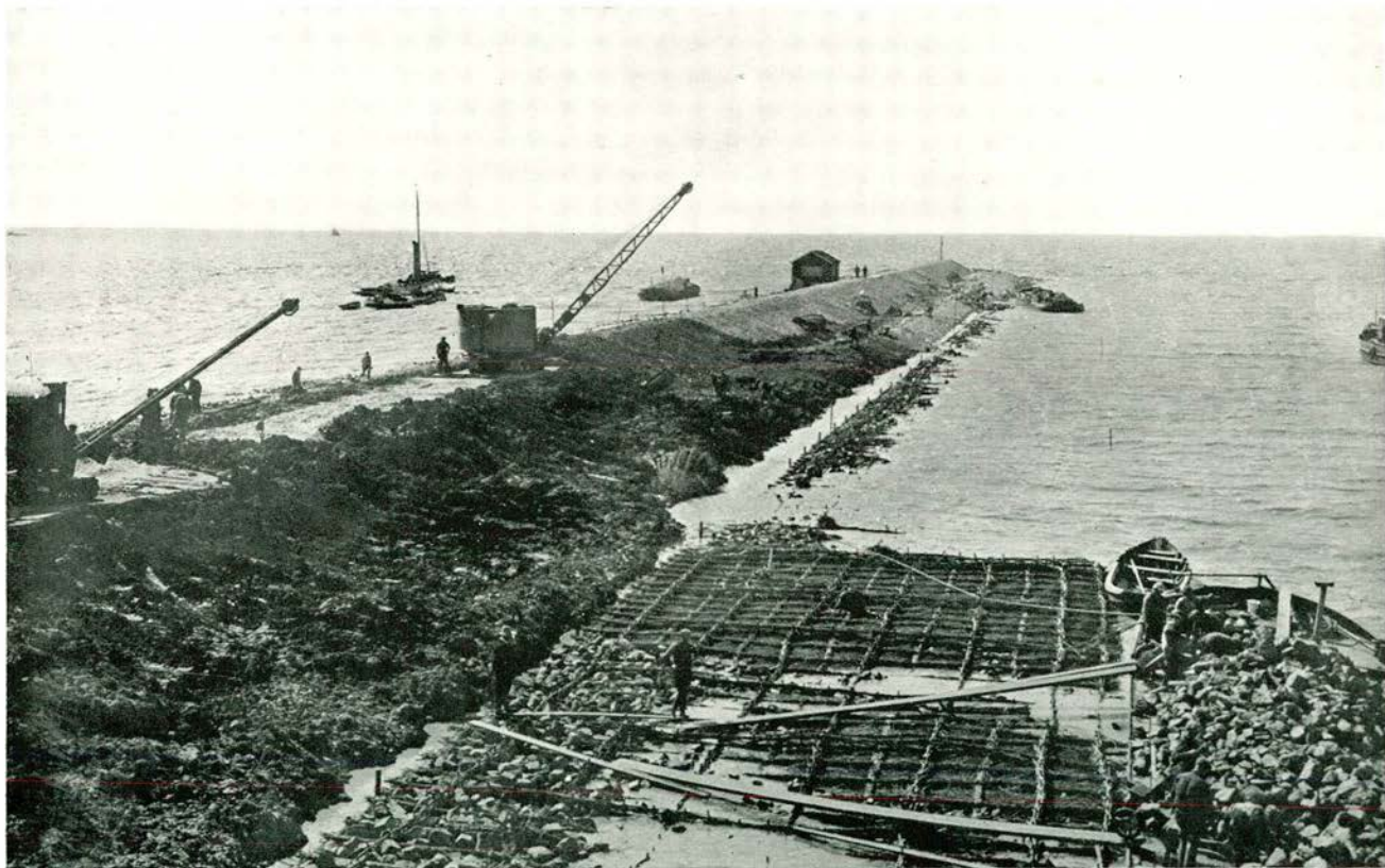
8. Het aanbrengen van de bekleedingskeileem met draglines op het dijksvak nabij Schokland.
