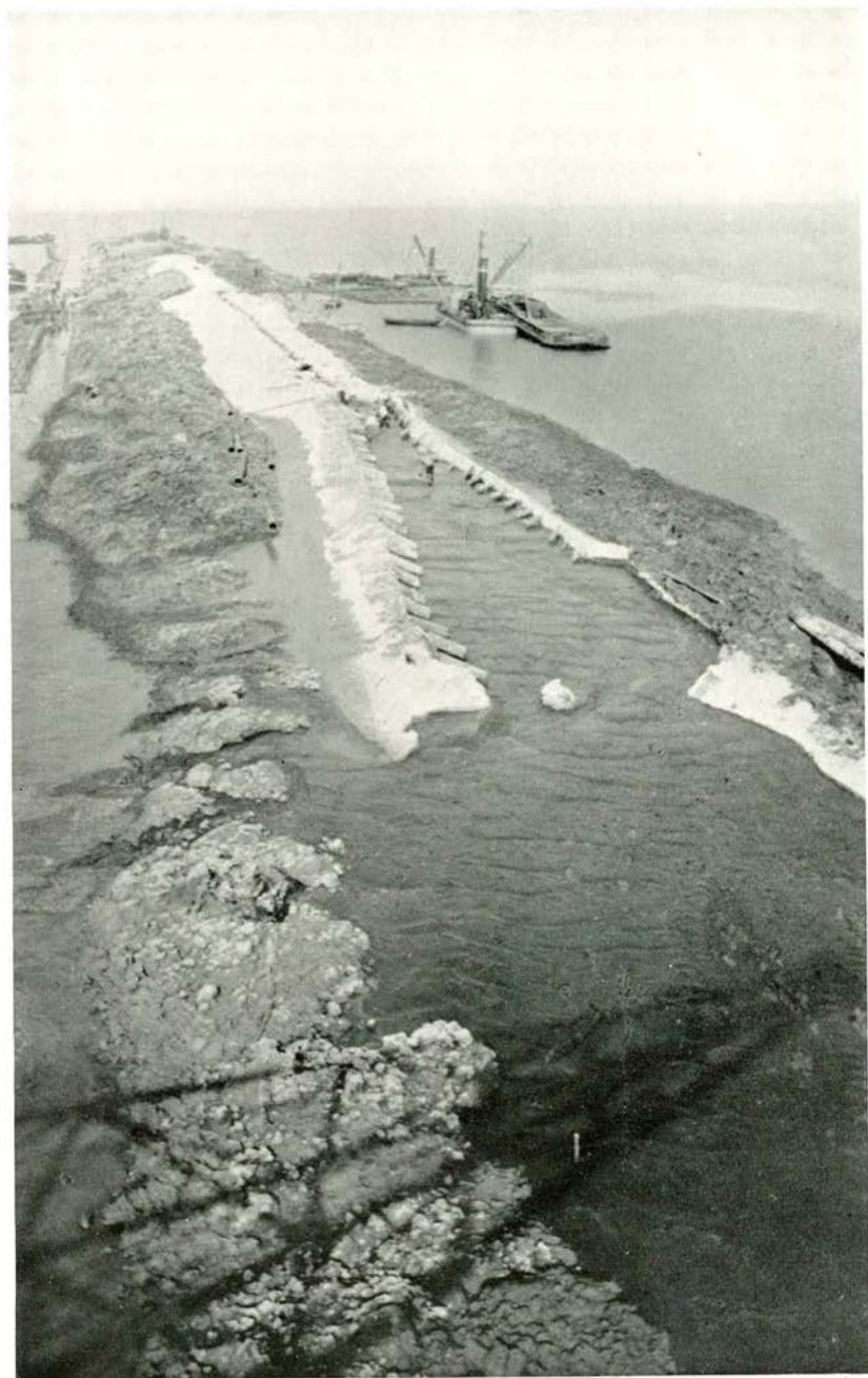
7. Het opwerken van het zandlichaam van het dijksvak nabij Schokland.
