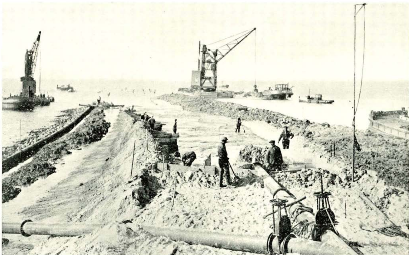
N o . 2. Opwerken van den dijk bij Lemmer.
