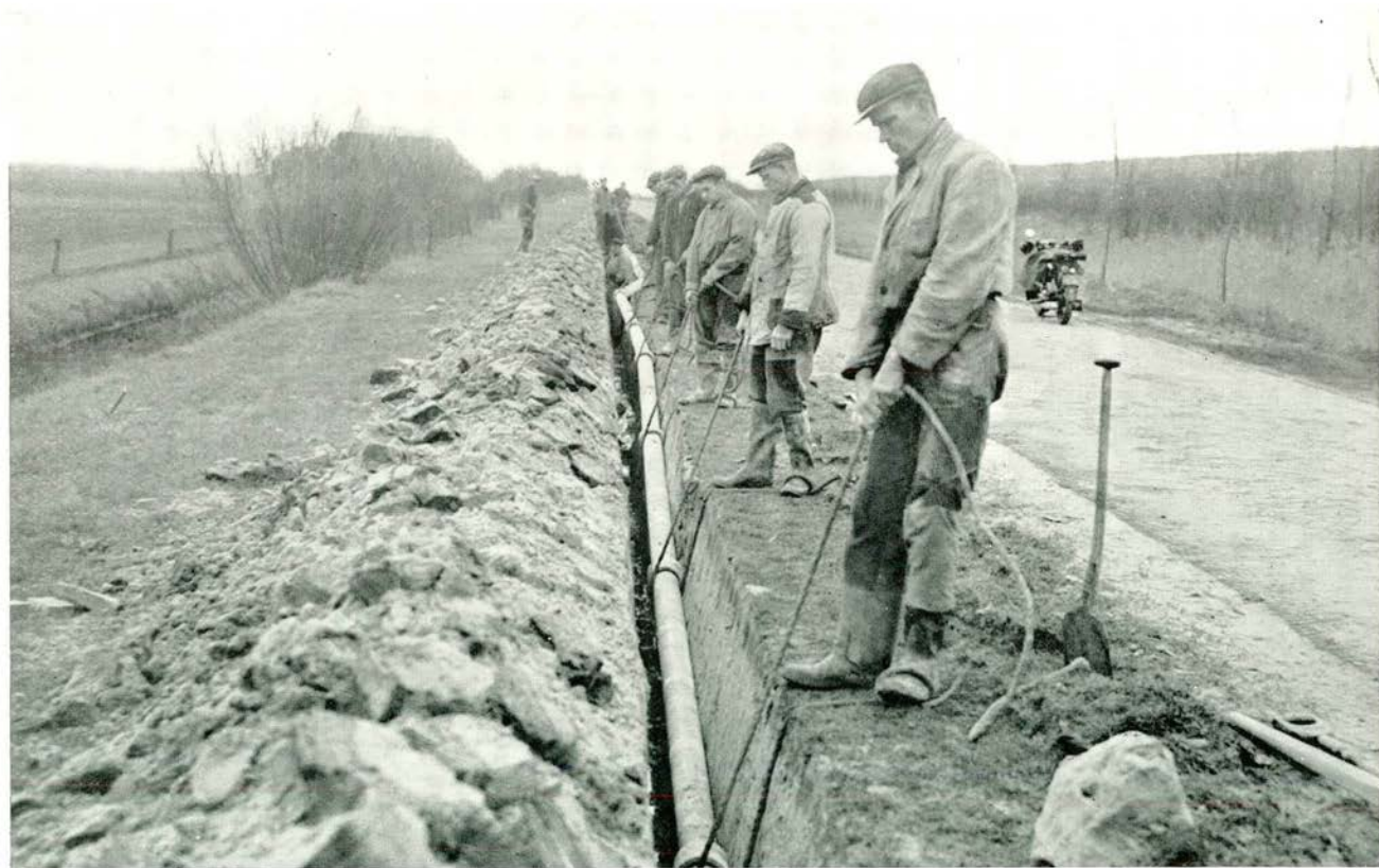
6. De aanleg van waterleiding in den Amstelmeerweg.
