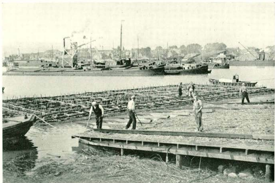
N o . 2. Het kraagstuk te water gelaten. De balken, waarop het gemaakt is, worden opgetrokken en weder op de rollen gelegd. (Zie blz. 12.)
