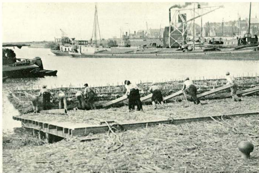
N o . 1. Een op de helling gemaakt kraagstuk wordt te water geschoven. (Zie blz. 12.)
