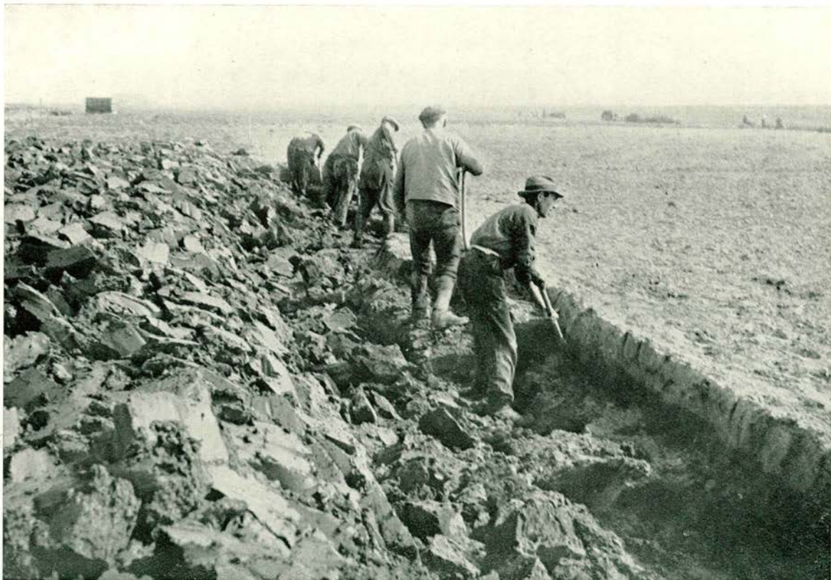
N o . 5. Het diepspitten (in werkverschaffing) in de Wieringermeer, waarbij de zand-bovengrond naar beneden en de klei-ondergrond naar boven wordt gebracht.
