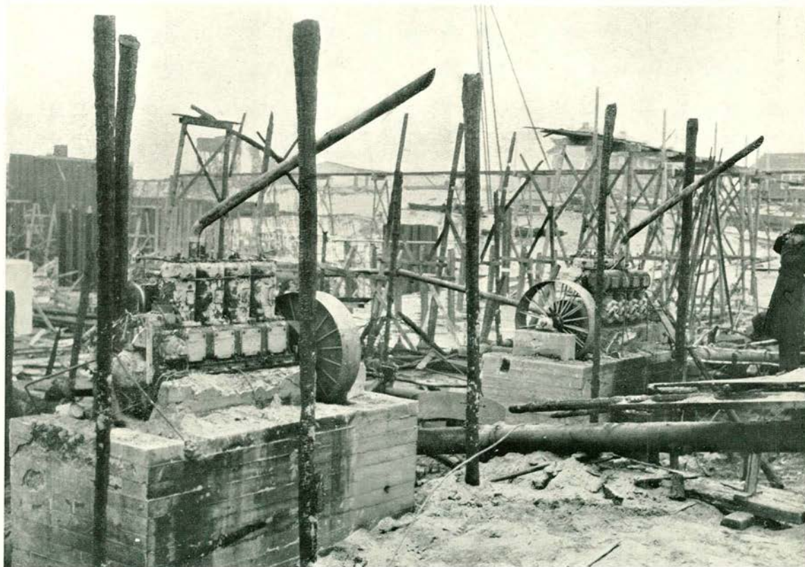
N o . 1. Een der beide verbrande pomplokalen van de bronbemaling in den fundeeringsput te Urk, waarin twee motoren van 120 pk waren opgesteld (19 December 1939).
