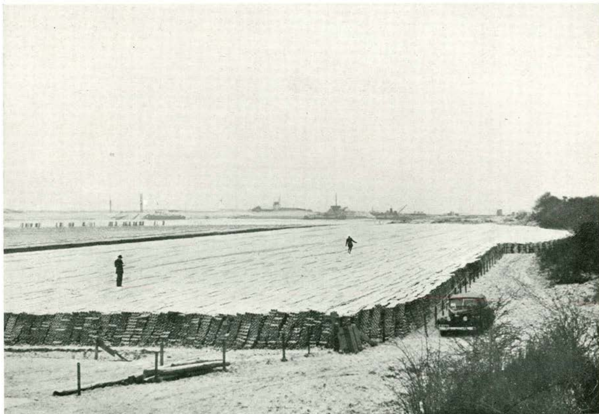
No. 7. Opslagterrein van draineerbuizen nabij de Voorst. Op den achtergrond de sluis- en gemaalput ten behoeve van den N. O. Polder.
