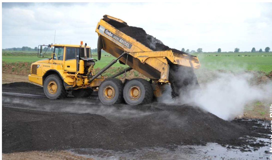
Figuur 2.3 Aanbrengen van TGG in het project Overdiepse polder. Het materiaal lijkt nog warm
