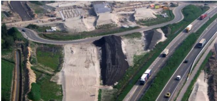
Figuur 4.24 Werkzaamheden aanleg knooppunt Princeville april 2002 (bron: beeldbank RWS, ID260756)
