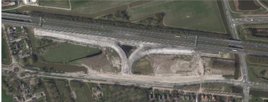
Figuur 4.22 Luchtfoto werkzaamheden aanleg afrit 7, 2016 (bron: globespotterGlobespotter )
