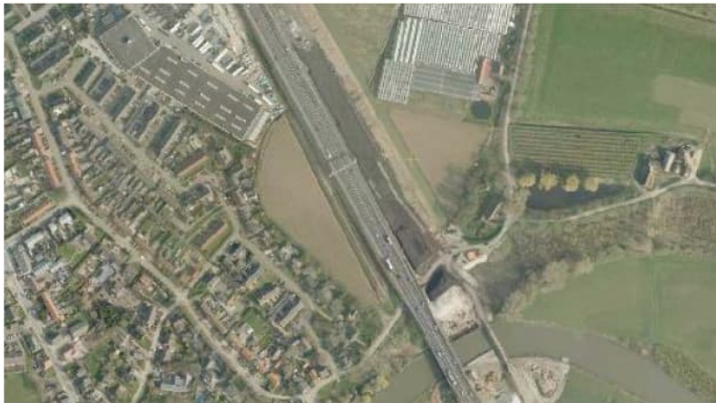
Figuur 4.7 Luchtfoto 2008 (bron: Globespotter), A2 aanleg brug over de Linge
