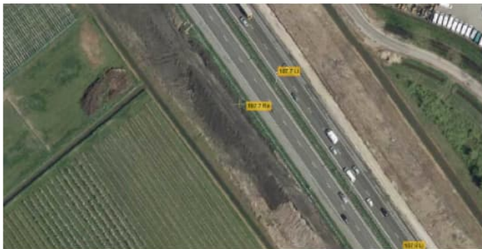
Figuur 4.1 Luchtfoto 2009 (bron: Globespotter), verbreding A2, km 107.7
