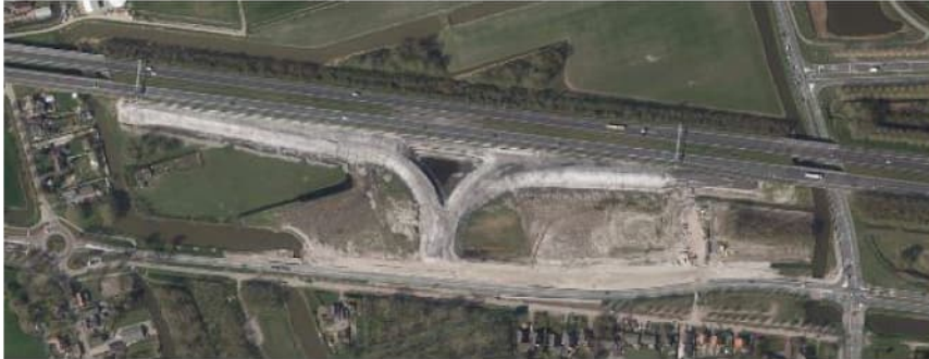
Figuur 4.22 Luchtfoto werkzaamheden aanleg afrit 7, 2016 (bron: globespotterGlobespotter )
