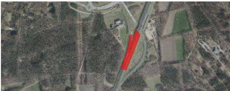
Figuur 4.12 Luchtfoto 2017 (bron: Globespotter), Knooppunt Paalgraven. In rood de toepassing van TGG
