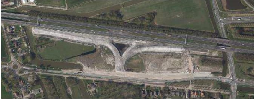
Figuur 4.22 Luchtfoto werkzaamheden aanleg afrit 7, 2016 (bron: globespotter Globespotter )
