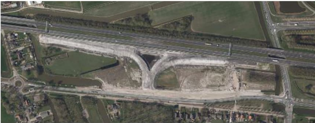
Figuur 4.22 Luchtfoto werkzaamheden aanleg afrit 7, 2016 (bron: Globespotter)
