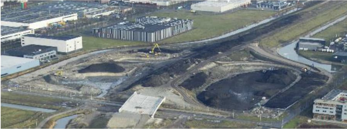
Figuur 4.11 Werkzaamheden aanleg Westrandweg km 13.5, 10 januari 2011 (bron: beeldbank Rijkswaterstaat)
