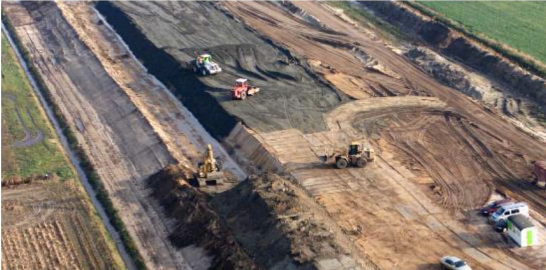
Figuur 27 Zandbaan tussen de Leijgraaf en viaduct Hoogstraat (bron: beeldbank RWS, ID269471, 20 november 2002, [redacted])
