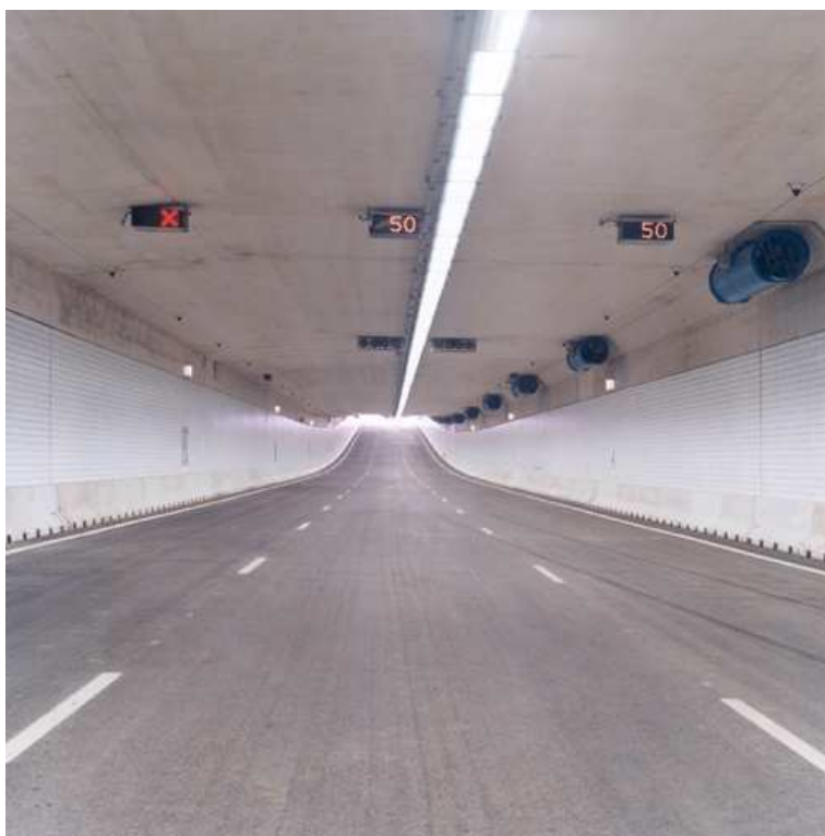
Tunnel de Noord
