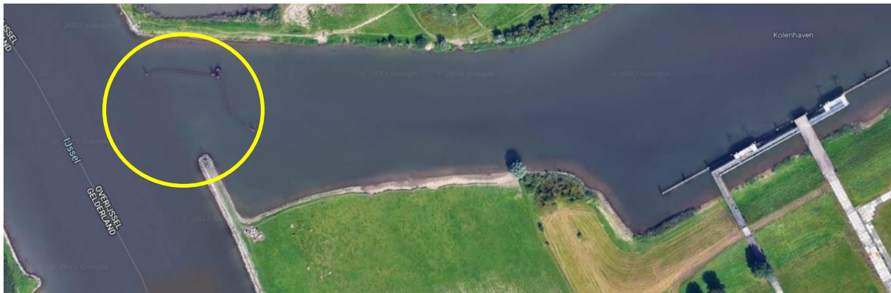
Figuur 1.1 De plasticvanger van Clear Rivers (omcirkeld in geel), afgemeerd naast de IJssel, bij de ingang van de Kolenhaven Bron: Google (z.d.).
