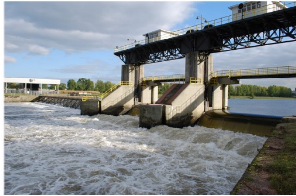
Figuur 9 Stromingsbeeld benedenstrooms van de stuw bij Roermond bij hoge afvoer (foto F.T. Vrieze ATKb)
