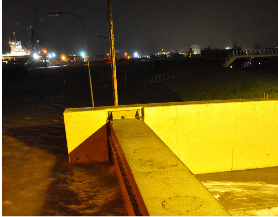
Figuur 8 Gesloten coupure bij Delfzijl op 6 december 2013
