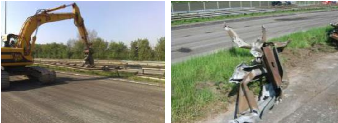
Afbeelding 3.1 Links: knippen geleiderail, rechts: resultaat knippen. Bron: RWS (2021) Verslag validatieproject A79
