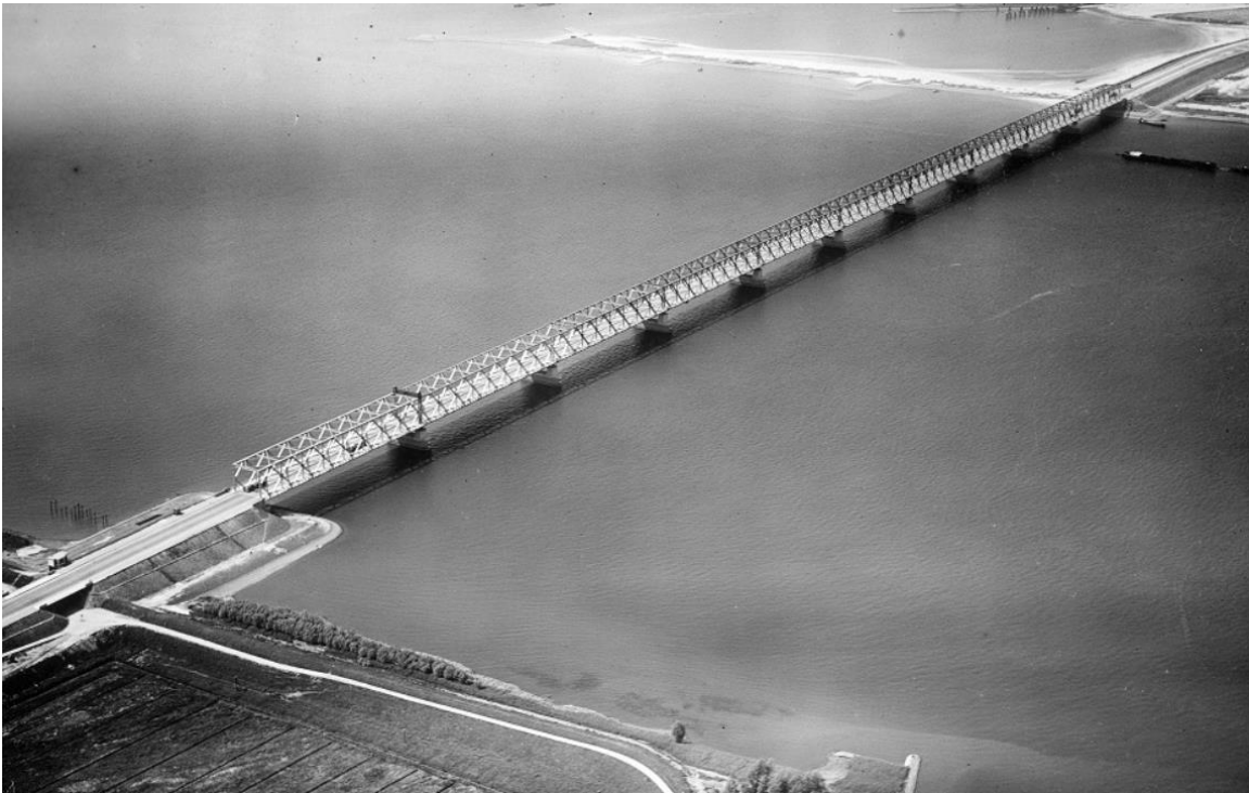
Afbeelding 2.1 Foto van de oude Moerdijkbruggen (bouwjaar 1936), bestaande uit 10 vakwerkbruggen. Deze 10 bruggen zijn in 1978 allemaal hergebruikt en momenteel nog steeds in gebruik
