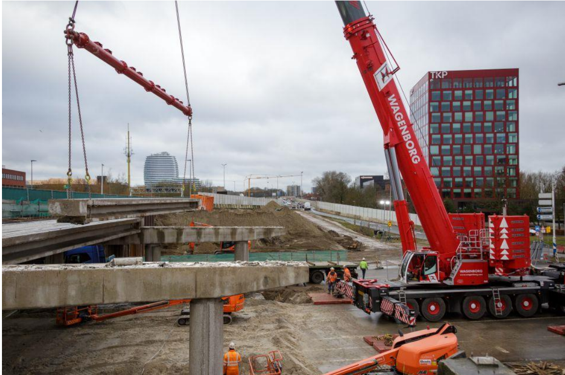
Afbeelding 3.1 Oogsten van liggers Ring Groningen (bron: https://www.cementonline.nl/liggers2_0 )
