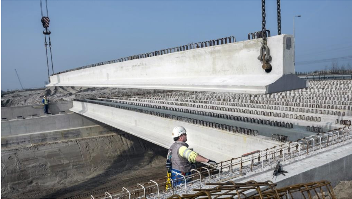
Afbeelding 1.1 Hier wordt een prefab betonnen ligger (omgekeerde T-ligger) geplaatst bij de bouw van een viaduct. Bron: RWS
