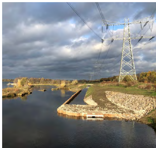
Vispassage Molenplas, aangelegd door waterschap Limburg in samenwerking met Rijkswaterstaat. Via een nieuw 2 km lang verbindingsbeekje kunnen vissen voortaan rechtstreeks van de Maas naar de Oude Maas zwemmen, naar de plekken waar ze zich voortplanten | ©Natuurmonumenten
