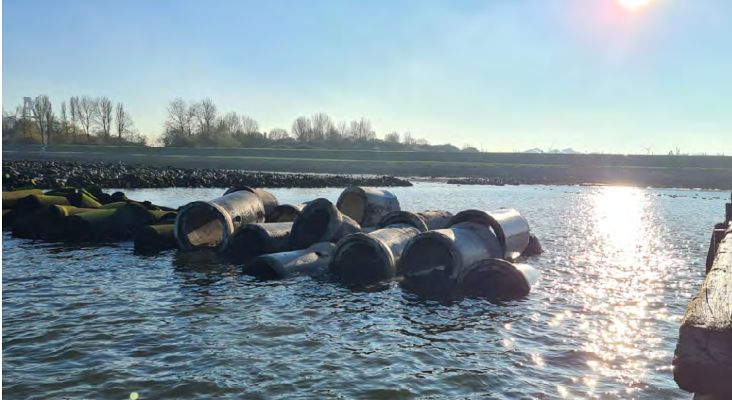
Delen van oude Rotterdamse rioolbuizen liggen langs de oever van Landtong Rozenburg om een langsdam te vormen, waarachter een luw gebied kan ontstaan
