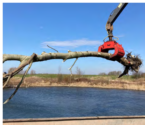
Plaatsing van rivierhout bij de Sandenburgerwaard | Martens en Van Oord
