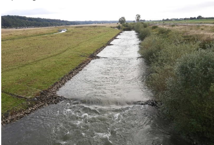
Figuur 8 Vispassage bij Driel werkt zoals hoort bij apexhoogte van de bypass op 7,05 m +NAP (foto: Bart Peters)
