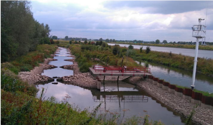
Figuur 11 Eerste drempel (2,56m NAP) en bypass (2,08m +NAP) van de vispassage bij Hagestein bij laagwater (foto: x)
