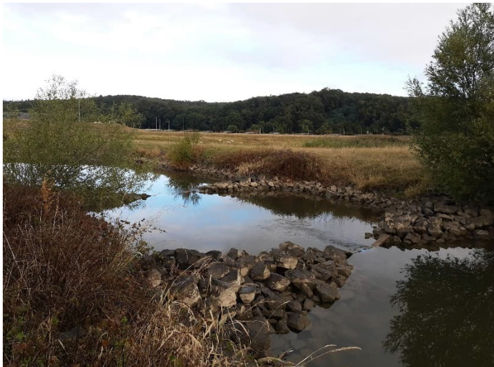
Figuur 7 Hoofdinlaet van de vispassage bij Driel voldoet niet aan de randvoorwaarden van apexhoogte 7,80 m +NAP (foto: Bart Peters)
