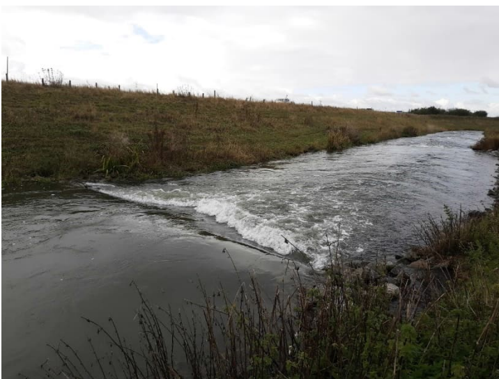
Figuur 10 Drempel (hoofdinlaat = 5,56m +NAP) van de vispassage bij Amerongen bij een voldoende waterstand (foto: Bart Peters)
