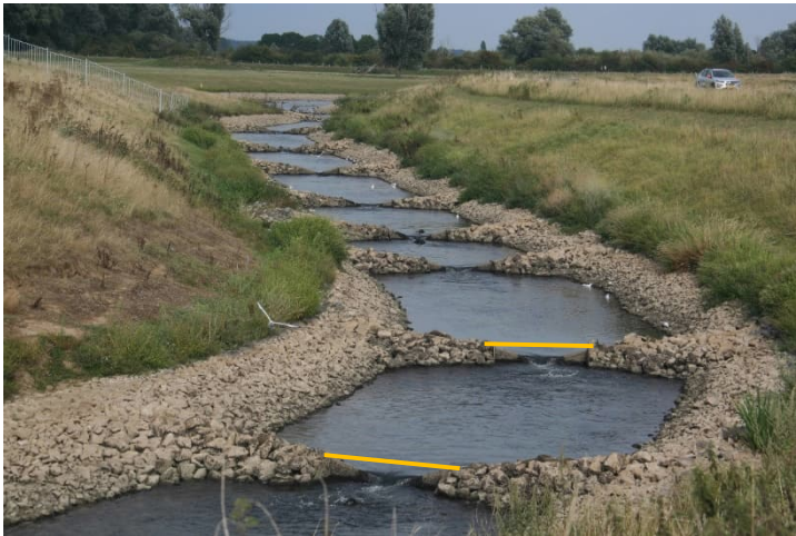
Figuur 9 Uitstroom van de vispassage bij Amerongen bij laagwater (hoofdinlaat = 5,56m +NAP) (foto: van Dénes Beyer)
