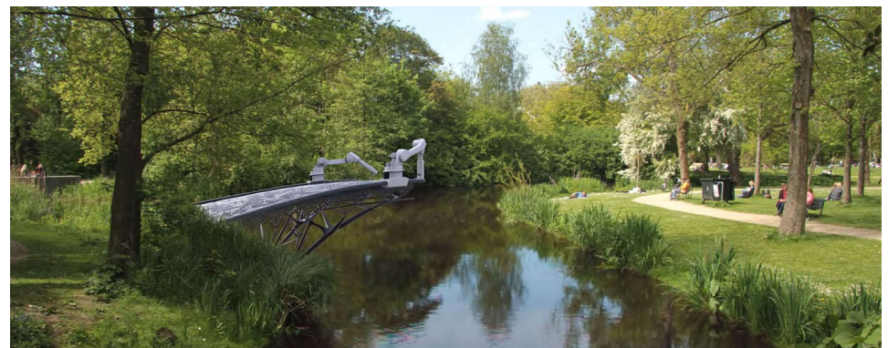
In Amsterdam zal over één van de grachten met 3D-technologie een nieuwe brug worden gebouwd, waarbij materiaalgebruik wordt geoptimaliseerd. Het Nederlandse ontwerp bureau MX3D en de bouwgroep Heijmans hebben de brug ontwikkeld.
