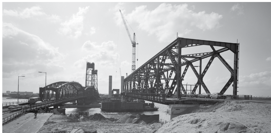
Foto Spijkenisserbrug: bij de aanleg van de nieuwe brug in 1977 werden vier van de tien oude bruggdelen van de Moerdijkbrug gebruikt, die eveneens vervangen werd; de overige zes bruggdelen werden gebruikt voor het vervangen van de Brug bij Keizersveer. [Beeldbank RWS]
