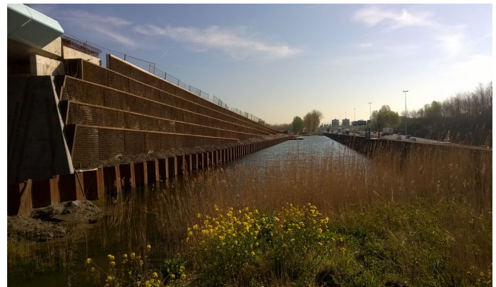
Groene wand bij parallelstructuur A12 Gouda voorzien van bioblocks.
