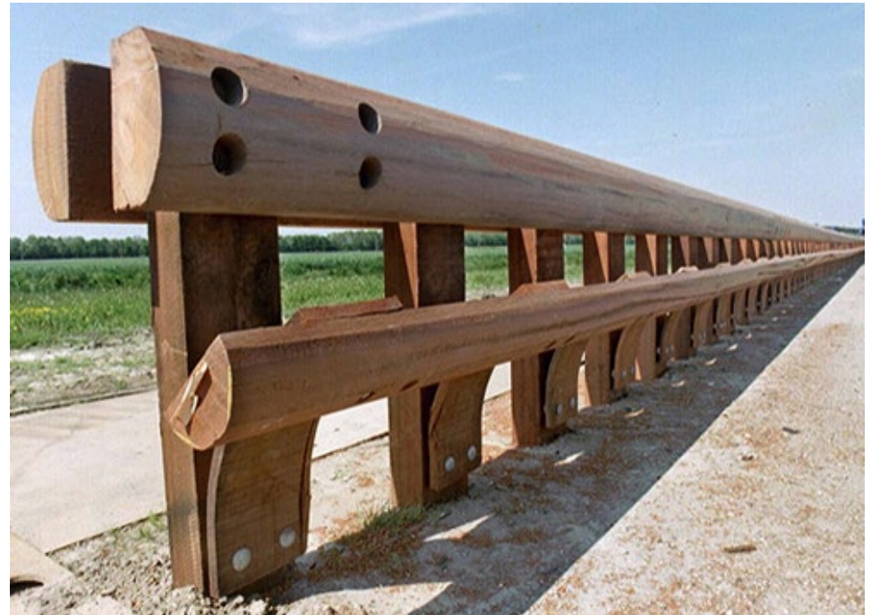
Houten geleiderail voor auto(snel)wegen, ontwikkeld in samenwerking met de TU Delft en getest door TNO-Wegtransport bij de Rijksdienst voor Wegverkeer in Lelystad. Een voorbeeld van het gebruik van biobased producten.
