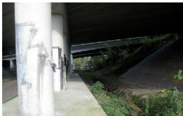
Zone tussen fietspad en landhoofd
