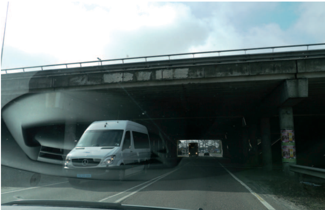
Kunstwerken worden in geval van uitbreiding als een geheel beschouwd. De bestaande situatie en de uitbreiding vormen een eenduidig geheel.
