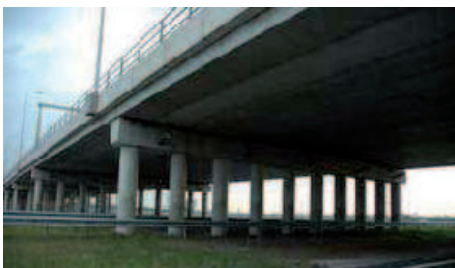
kolommen, liggers en rijdek zijn afzonderlijke onderdelen en vormen geen integraal geheel
