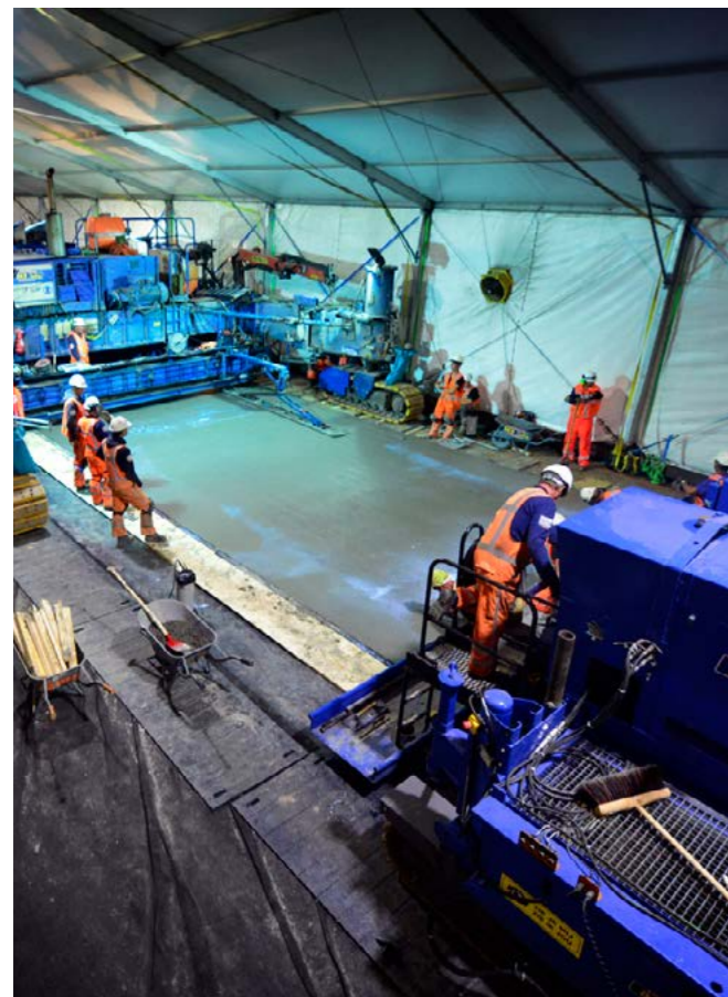
Aanbrengen van hogesterktebeton
