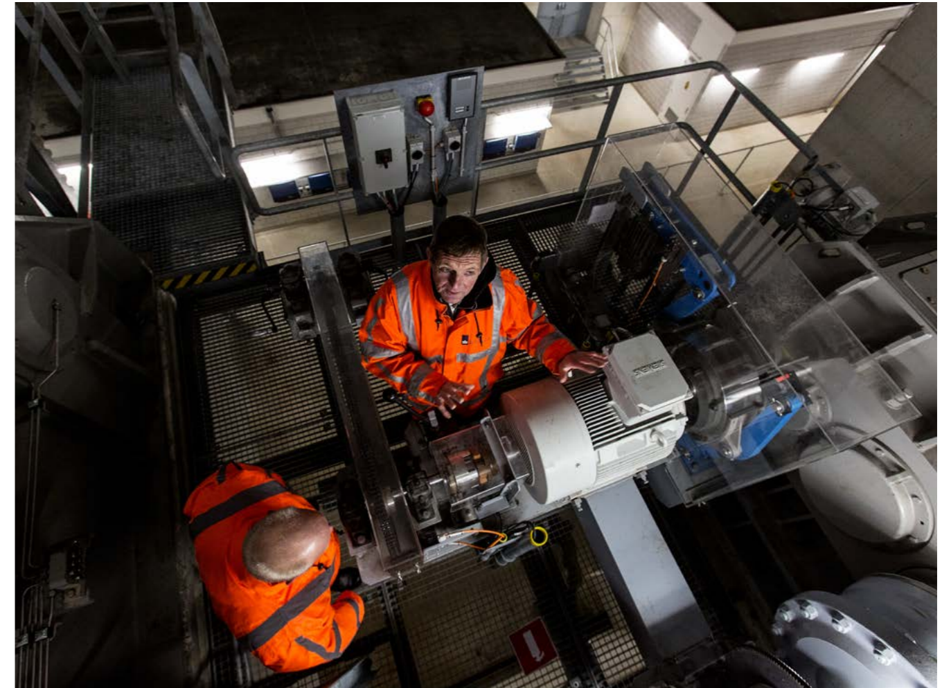
Inspectie van generatoren in de Ramspolbrug
