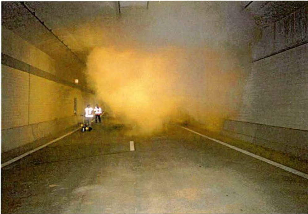
Fig. 19 De tunnel wordt, vanaf de Zuidzijde, met rook gevuld.
