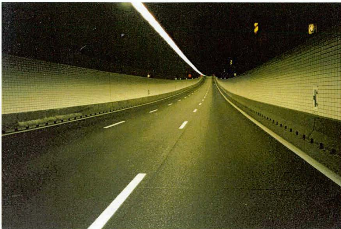
Fig. 1 Tunnel onder de Noord gezien vanaf de Westzijde, september 2001. Boven de hulpkasten witte bordjes; boven de vluchtdeuren groene bordjes. (De eerste vluchtdeur zit links, onder het derde bordje van links; de vluchtdeuren zijn vrijwel onzichtbaar.)
