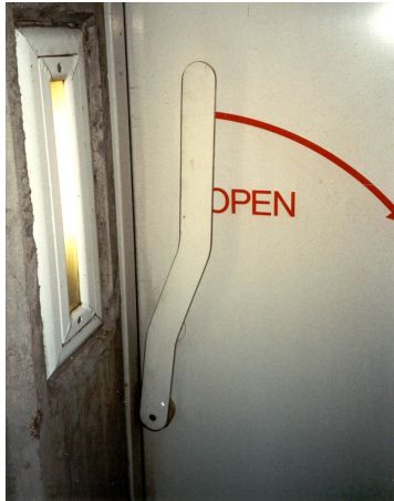
Fig. 7 Kruk van de vluchtdeur.
