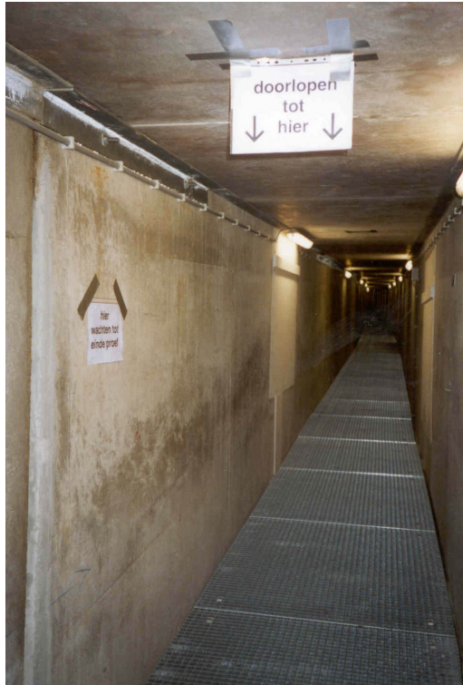
Fig. 21 Gebrek aan informatie in het vluchtkanaal. De borden aan het plafond en aan de wand waren alleen voor de proeven aangebracht.
