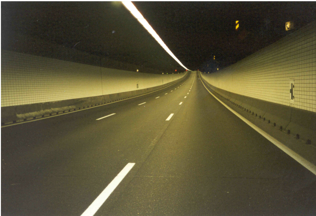
Fig. 1 Tunnel onder de Noord gezien vanaf de Westzijde, september 2001. Boven de hulpposten witte bordjes; boven de vluchtdeuren groene bordjes. (De eerste vluchtdeur zit links, onder het derde bordje van links; de vluchtdeuren zijn vrijwel onzichtbaar.)
