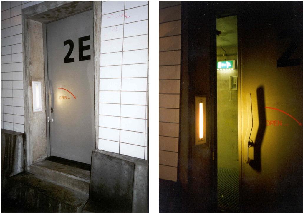
Fig. 8 Een vluchtdeur.
