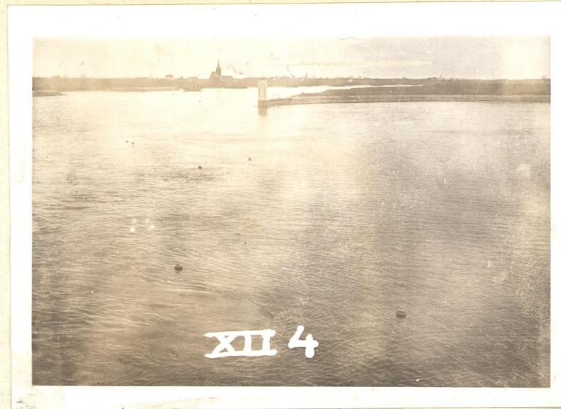
Foto's 1 en 2. Drijvermeting 12 april 1956. Losse drijvers kort na elkaar ingezet bij de bovenstroomse pijler op de rechteroever.
