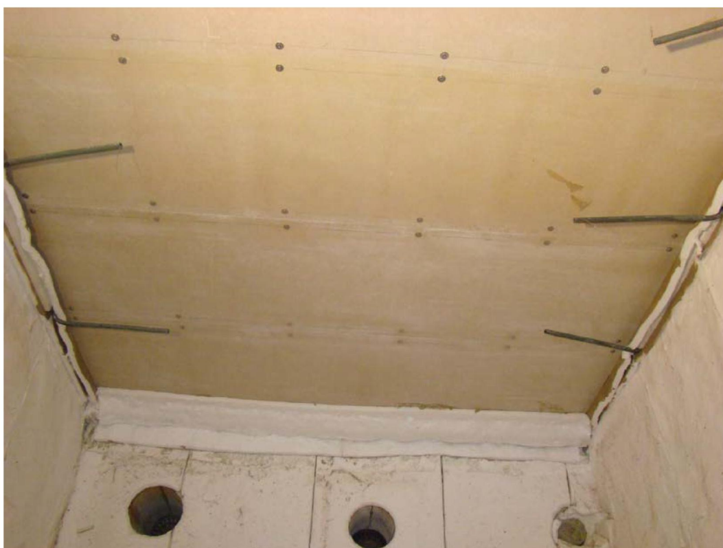
Foto 2: Verhit oppervlak voor de brandproef
