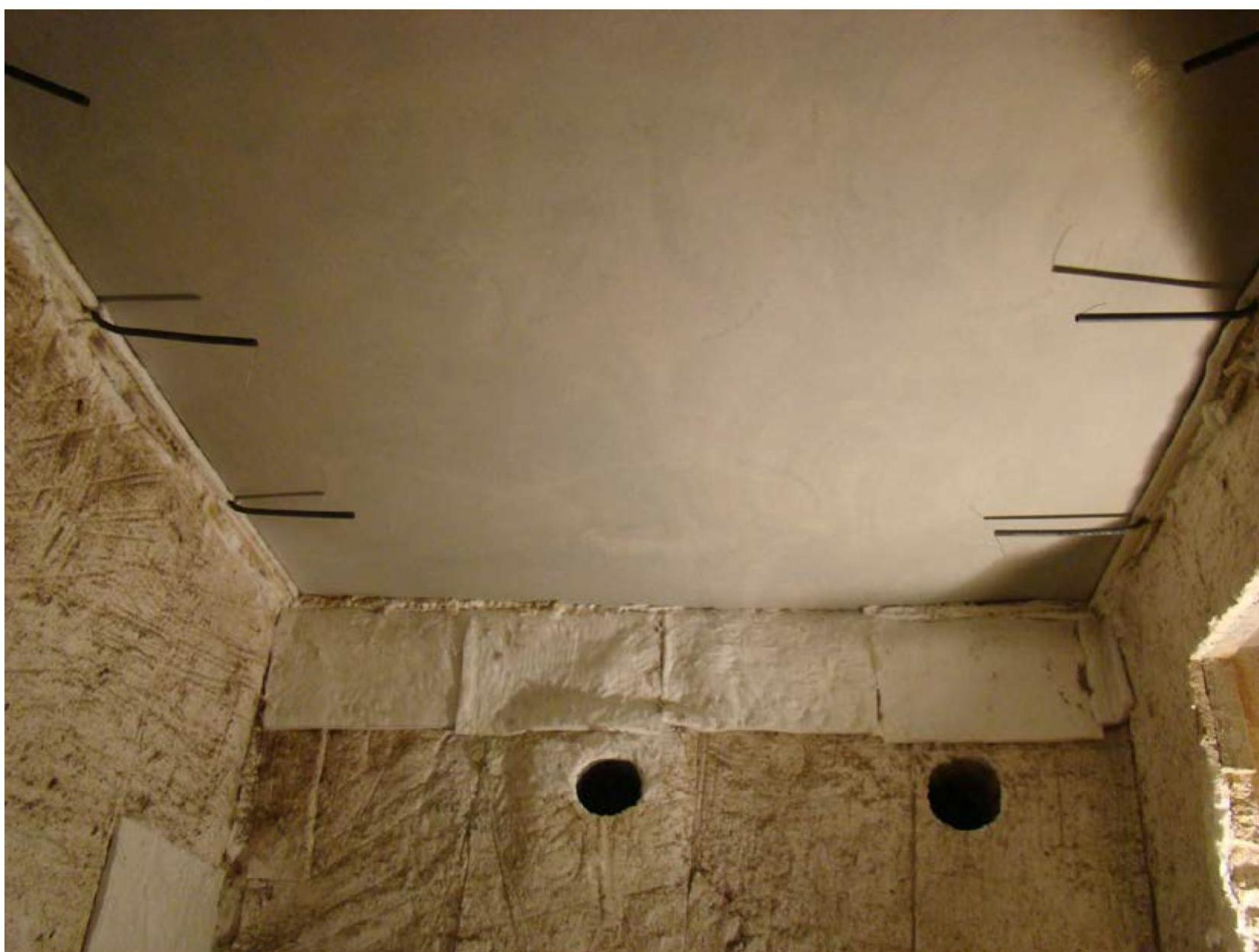
Foto 2: Verhit oppervlak voor de brandproef
