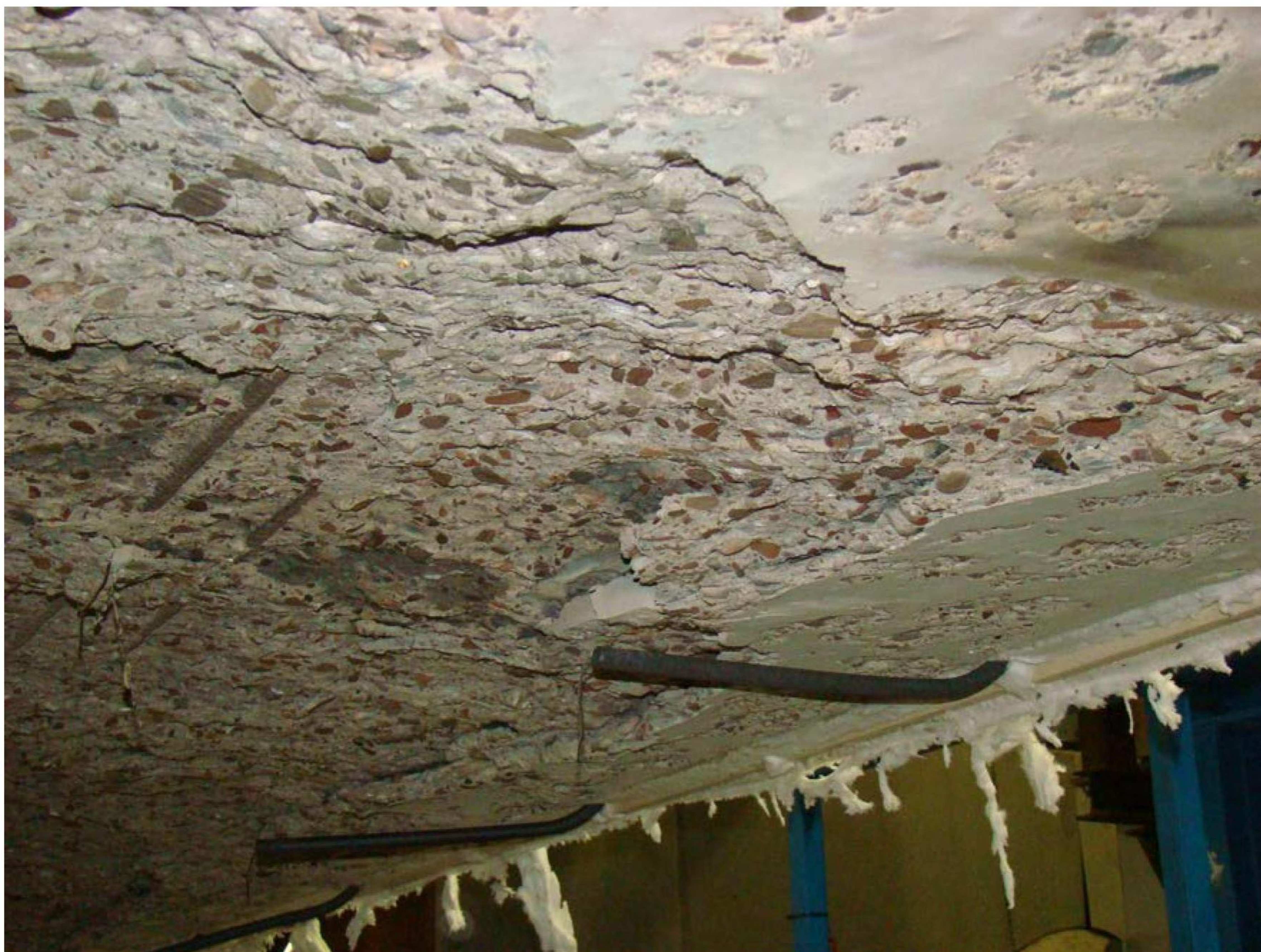
Foto : Details van het verhitte oppervlak na de brandproef
