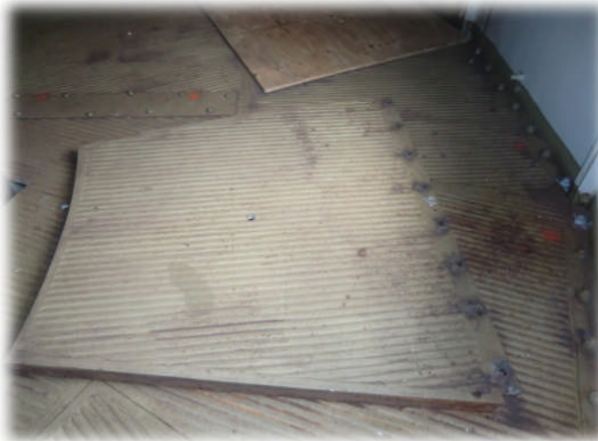
Vloerplaat 9A, uitgenomen
