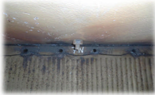
Plaat 7N, bouten verwijderd
