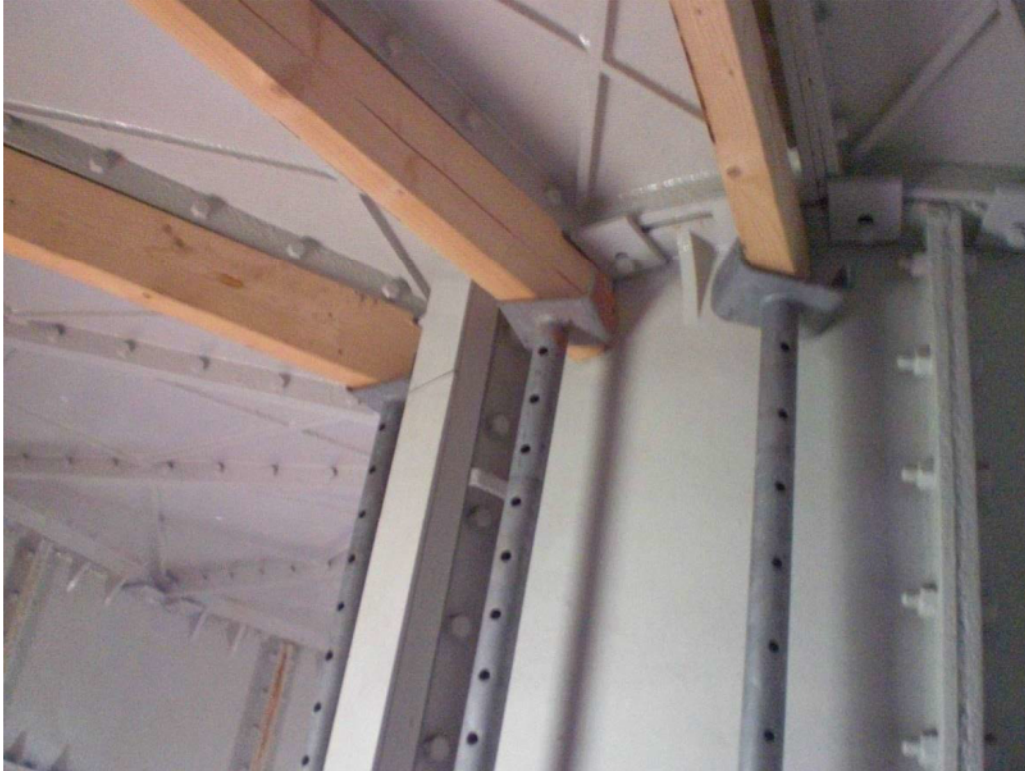
foto 3 Onderslag balken ter plaatse van de binnen schacht
