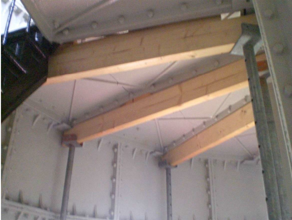
foto 1 onderslag balken ter plaatse van de ribben
