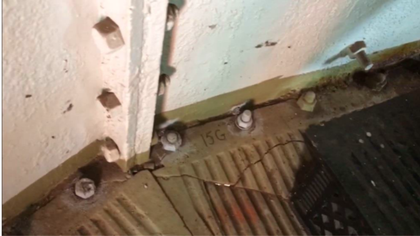
Figuur 6: bezwaken vloer op niveau 15 nabij transportroute
