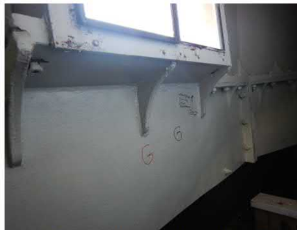
Figuur 4.2: Ontbrekende bout V-202109-844 (Niveau 2, Ring 1, paneel G)
