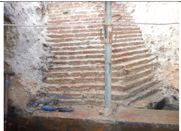
Figuur 9.4: Funderingsmetselwerk
