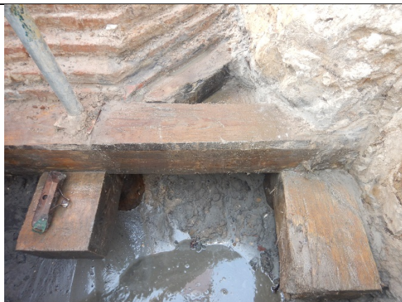
Figuur 9.23: Detail balkraaster
