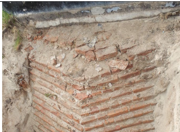
Figuur 9.3: Bovenzijde funderingsmetselwerk
