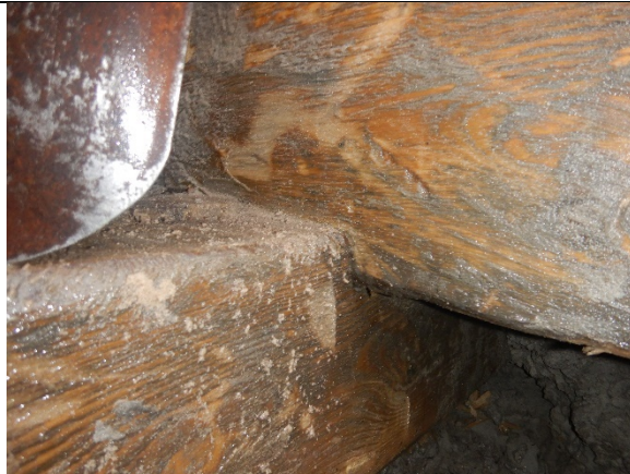
Figuur 9.19: Inkeping balklagen, kesp 1
