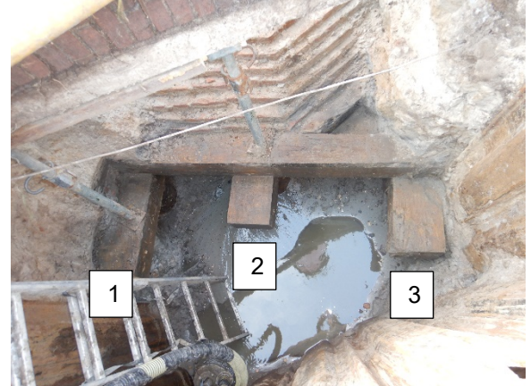
Figuur 9.2: Overzichtsfoto inspectieput
