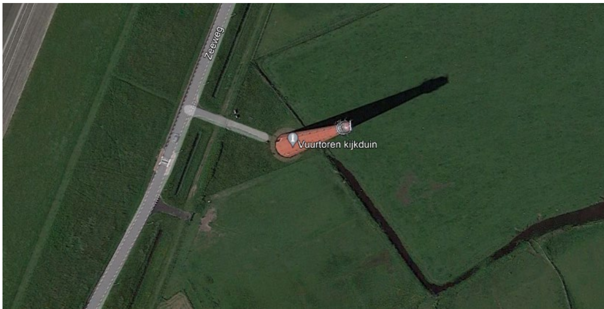
Figuur 1.1: Situatie vuurtoren de Lange Jaap aan de Zeeweg 5 te Huisduinen (Bron: Google Maps).
