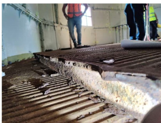
Foto 2: Scheuren blijven voor rib aan uiteinde
