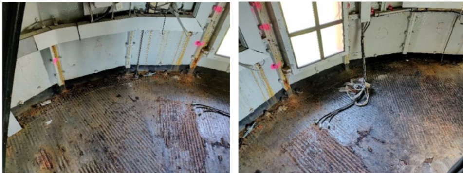
Foto 5 en 6: Scheuren langs de schachtwand
